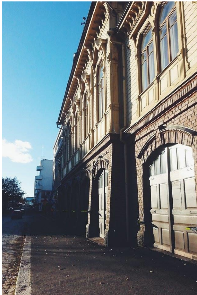
Kuva 15. Palokunnantalo, Palokunnankatu 18 (Laura Saali 27.10.2015).
