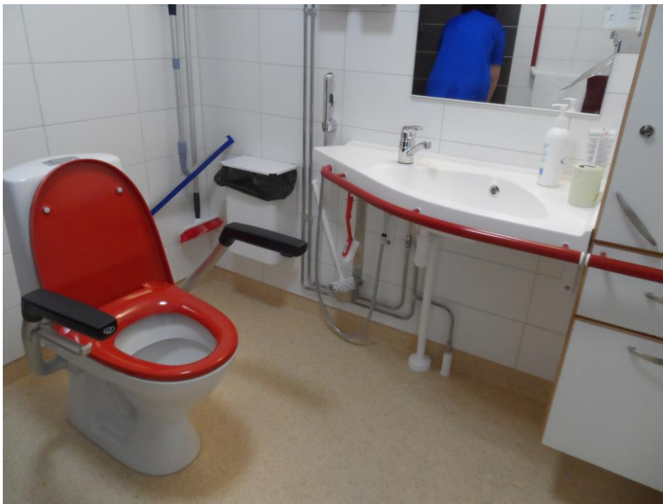
Kuva 23. Palvelutalo Jokihelmen toimivat wc-tilat, joissa wc-istuimen pystyy kiertämään ja värikkäät kahvat ja wc-istuin on helposti havaittavissa.
