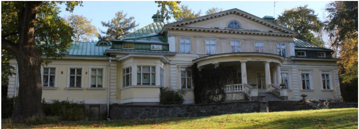
Kuva 2: Kartanon julkisivu lounaasta kuvattuna.
