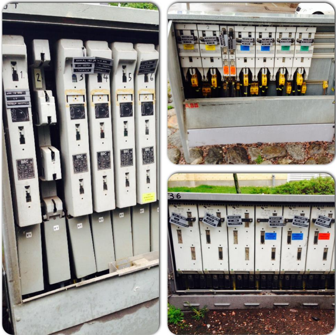
Kuva 9. SST-betonijalustainen jakokaappi, Kabeldon ja Triax
