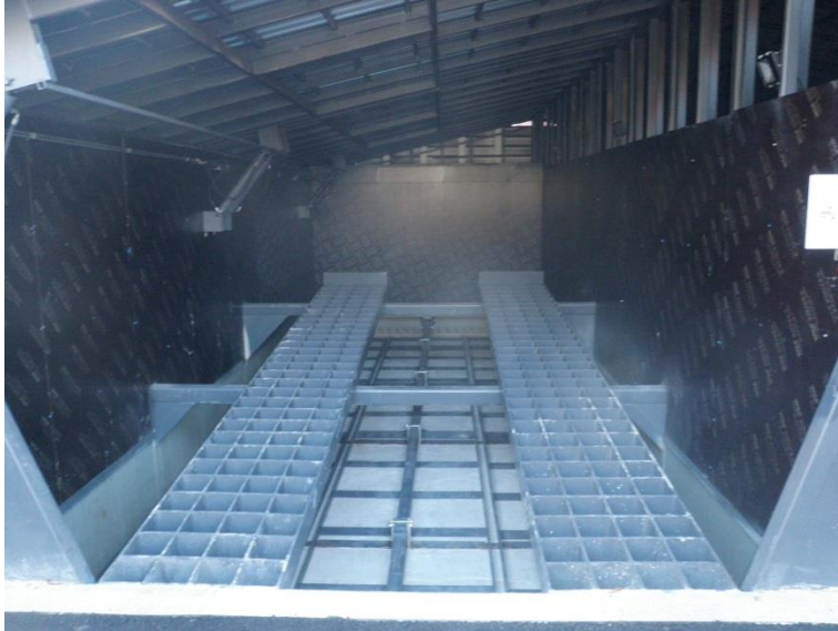
Kuva 6. Hakevaraston vasen puoli, ajorampit ja pohjapurkaimet.
