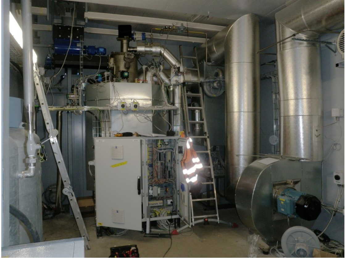
Kuva 8. Vasemmalla kaasutusreaktori, takakulmassa sykloni sekä oikealla edessä tuotekaasupuhallin.
