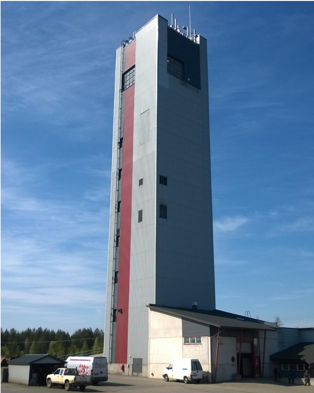
KUVA 2. Pyhäsalmen kaivos, nostokoneen tornirakennus
