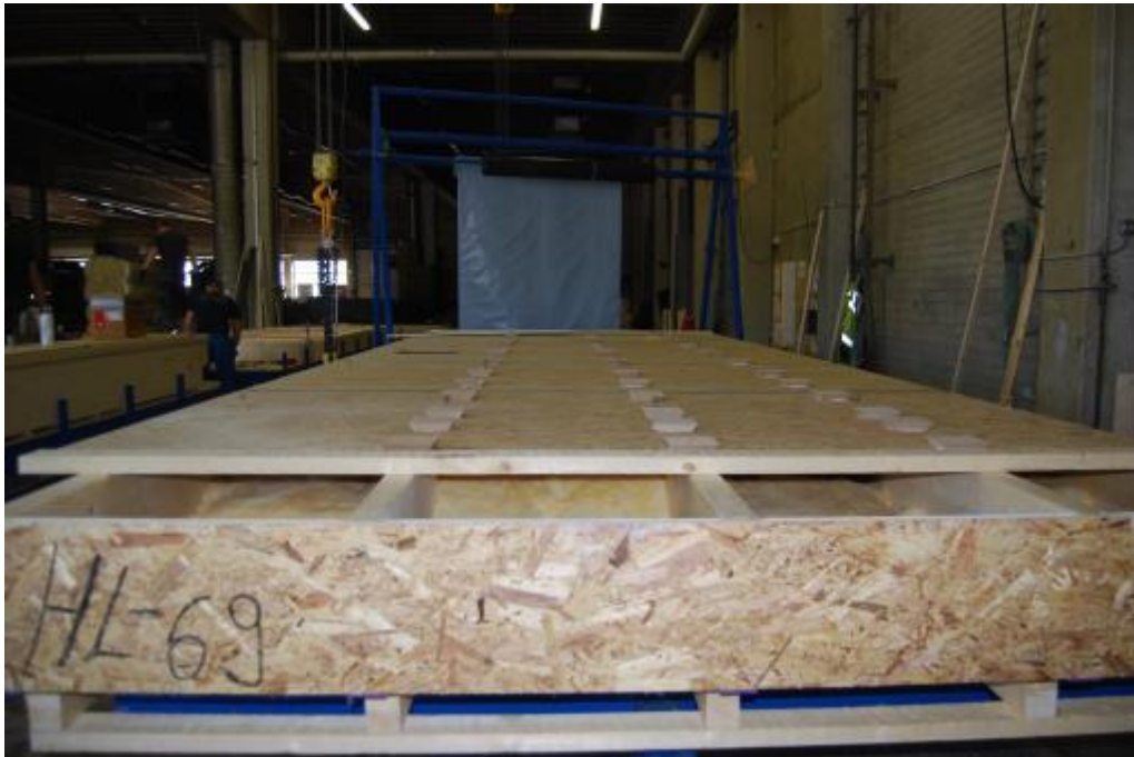
Kuva 9. Kuvassa on esitetty välipohjaelementti kasattuna VVR Wood Oy:n tehtaalla.
