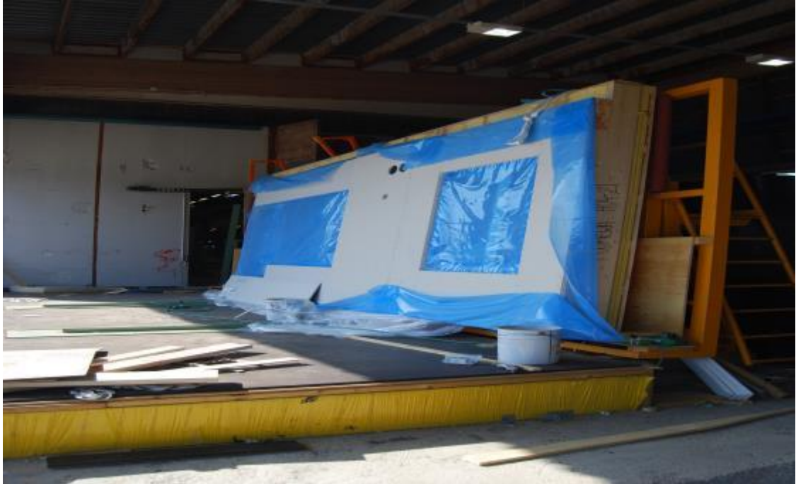
Kuva 7. Huoneiston ulkoseinän valmistusta Koskisen Oy tehtaalla.
