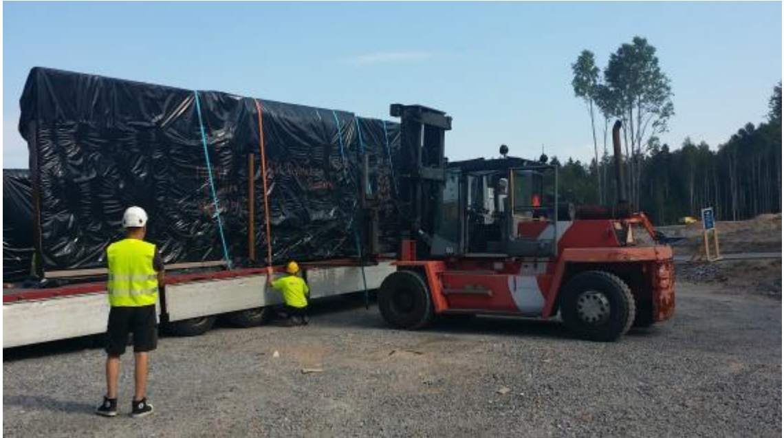
Kuva 20. Puuelementikuorman purku käynnissä työmaalla.
