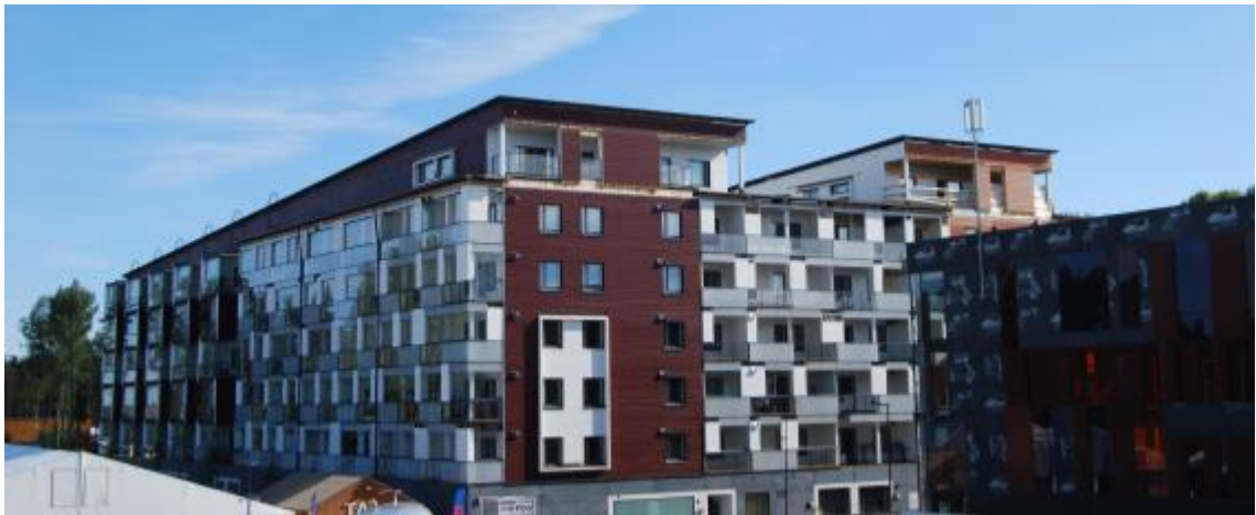
Kuva 1. Rakenteilla oleva Euroopan suurin puukerrostalo Vantaan Kivistössä.
