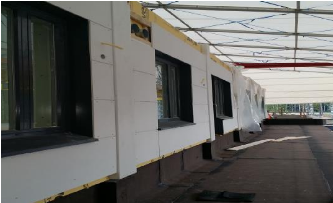
Kuva 8. Ulkoseinäelementti asennettu paikoilleen Kivistön kohteessa.
