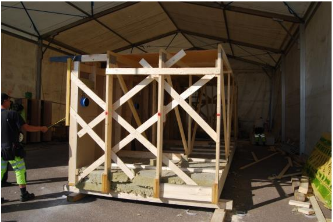
Kuva 10. Yläpohjajaelementin valmistusta Koskisen Oy tehtaalla.
