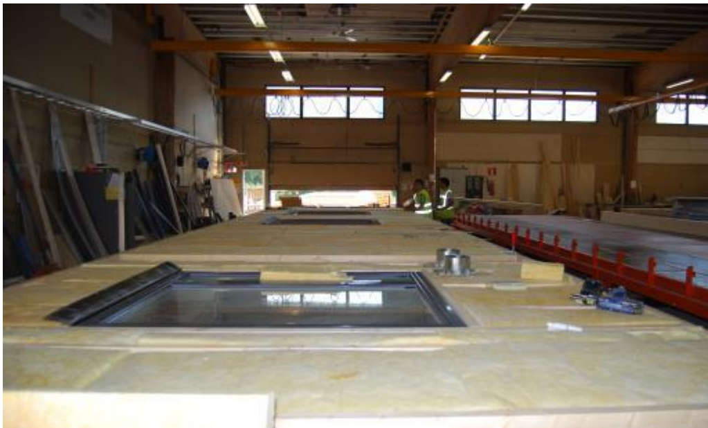
Kuva 4. Suurelementin valmistusta 14-metrisellä mittapöydällä Koskisen Oy:n elementtitehtaalla.
