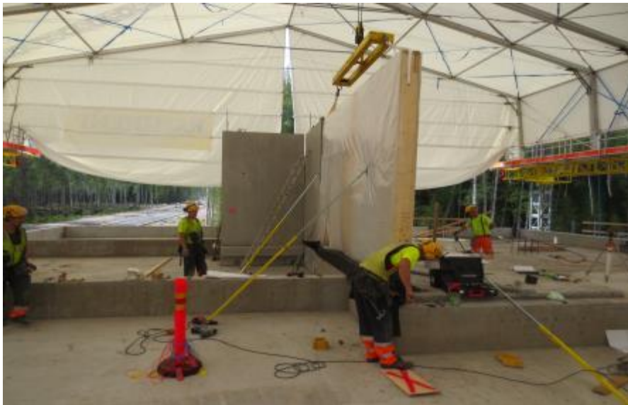
Kuva 23. Kuvassa on esitetty puuelementtien asennusaikainen tuenta.
