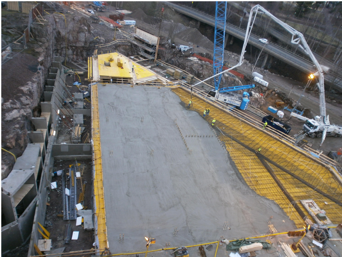
Kuva 2. Kuvassa valetaan autohallin kansirakenteita Pasilan konepajalla.
