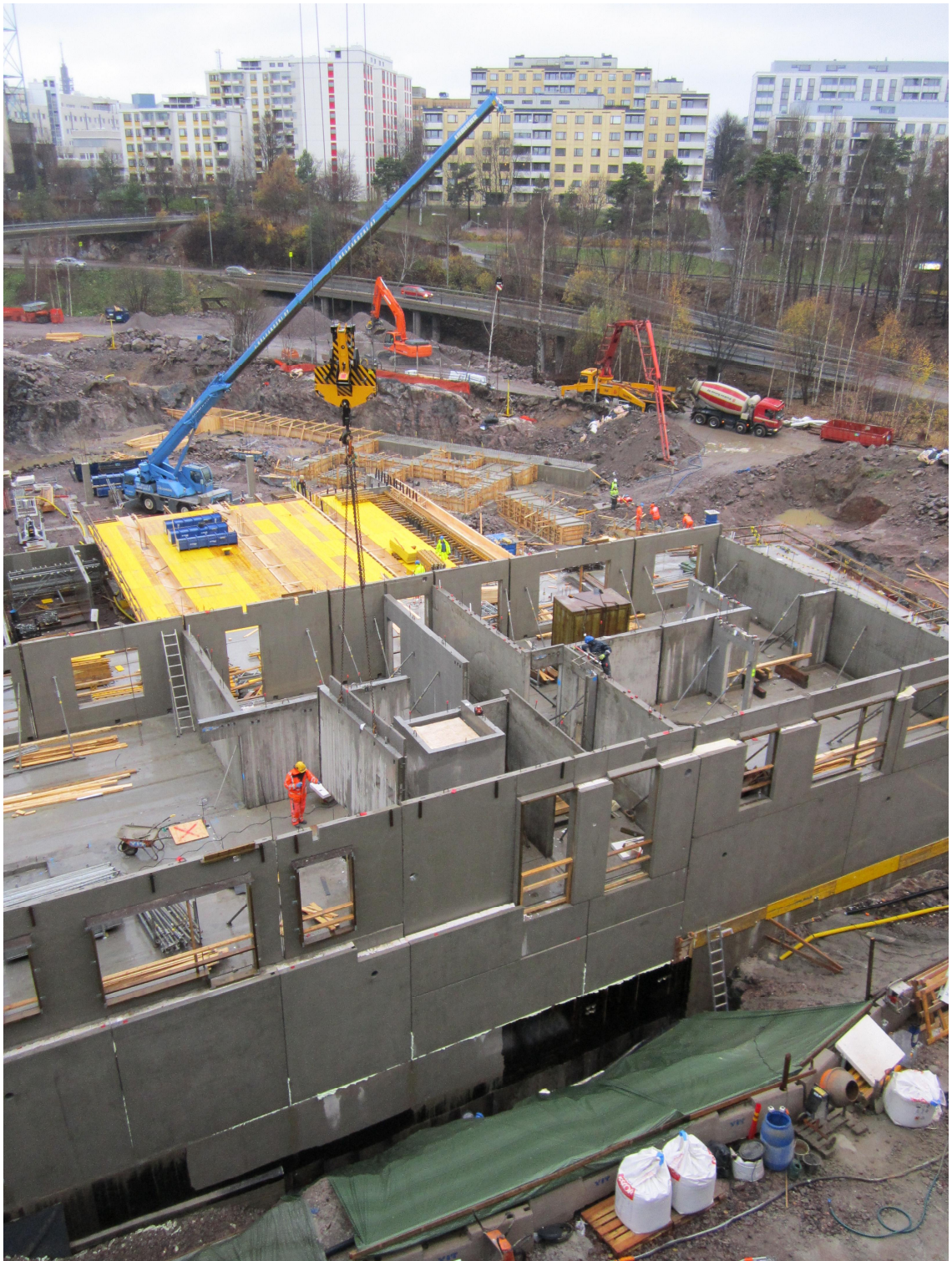
Kuva 1. Rakennustyömaalla on monia työvaiheita käynnissä samanaikaisesti, joten työturvallisuuden huomioiminen on erittäin tärkeää.
