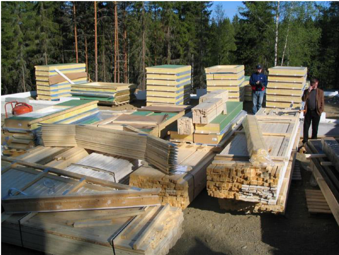
KUVA 1. Pienelementtejä työmaalla (Ainasoja. 2004)
