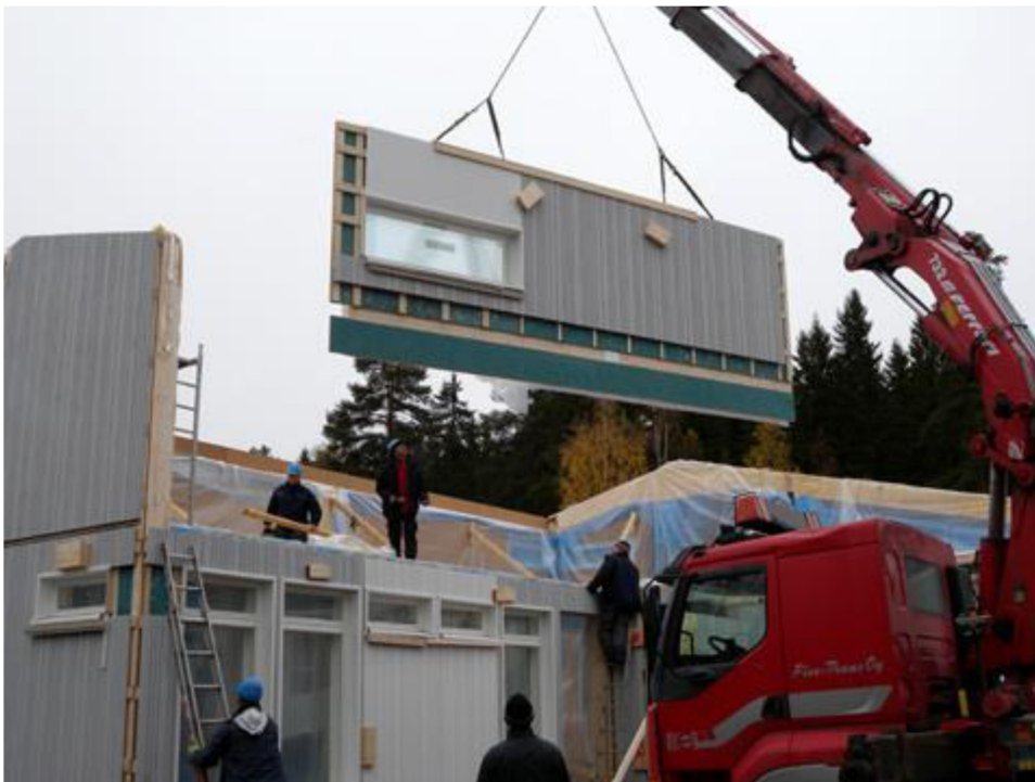
KUVA 2. Suurelementin nosto (Anttila. 2012)
