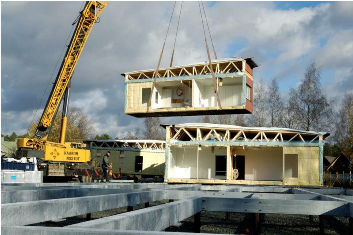
KUVA 3. Tilaelementtejä (Hölkki. 2008)
