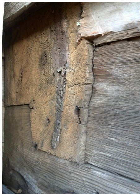
Kuva 11. Lahonnut hirsi julkisivu- Kuva 12. Hirsien nurkkaliitos laudoituksen alla
