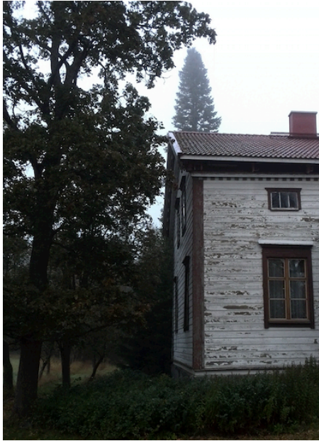
Kuva 4. Vaahtera rakennuksen päädyssä
