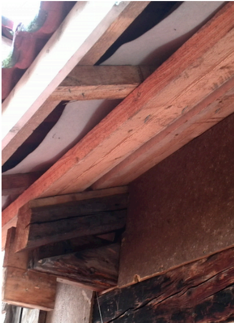
Kuva 15. Keskeneräinen räystäslaudoitus
