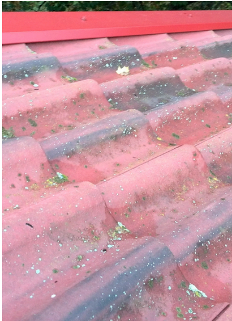
Kuva 24. Sammaloitunutta tiilikatetta
