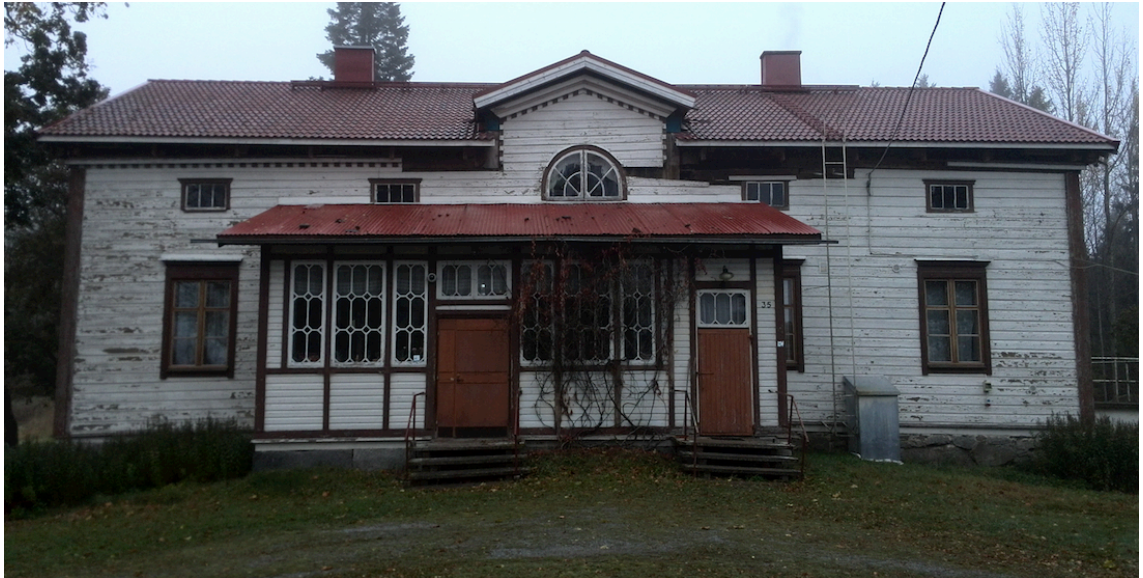
KUVA 1. Yleiskuva Sankilan päärakennuksesta (Kuva: Tuomas Heikkinen 2015)
