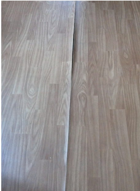
Kuva 32. Muovimaton auennut sauma
