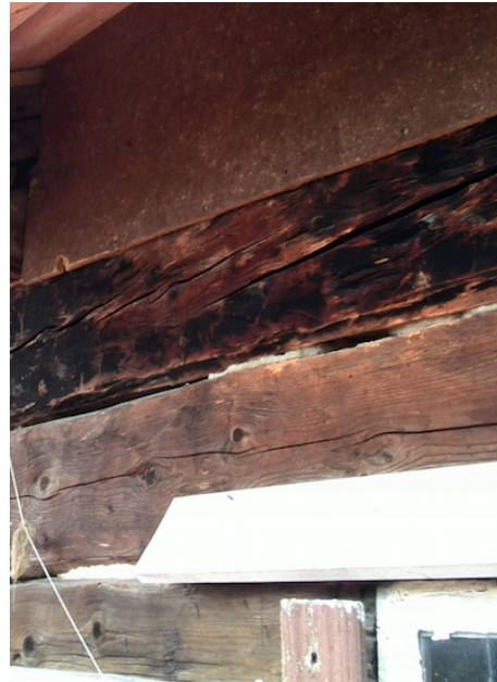
Kuva 16. Puuttuva julkisivulaudoitus
