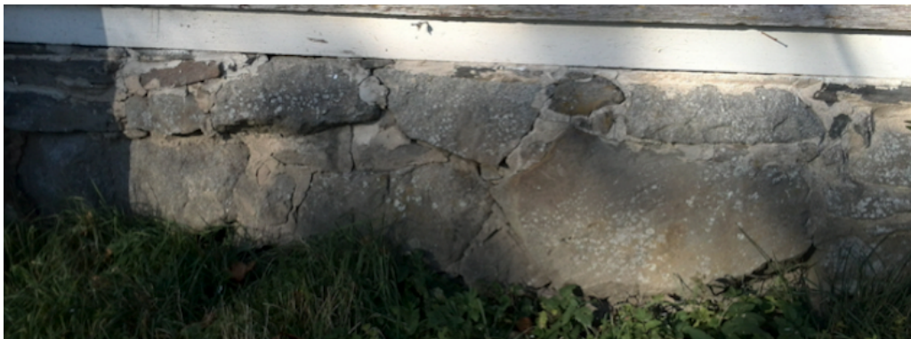
Kuva 7. Yleiskuva rakennuksen kivijalasta
