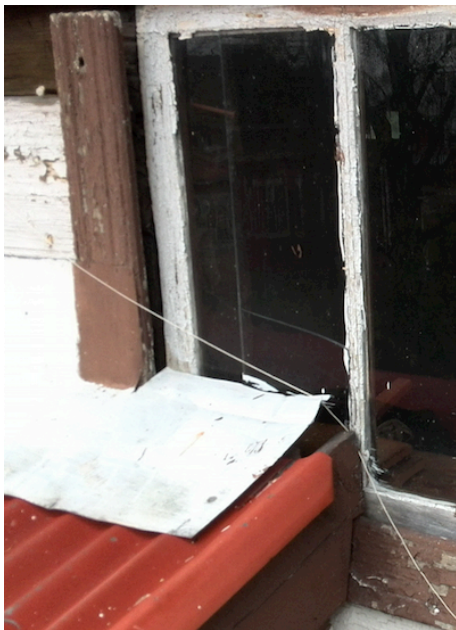
Kuva 18. Kuistin katon ja vintin ikkunan liitos
