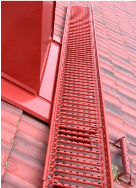
Kuva 26. Kävelysilta ja piipun pellitystä
