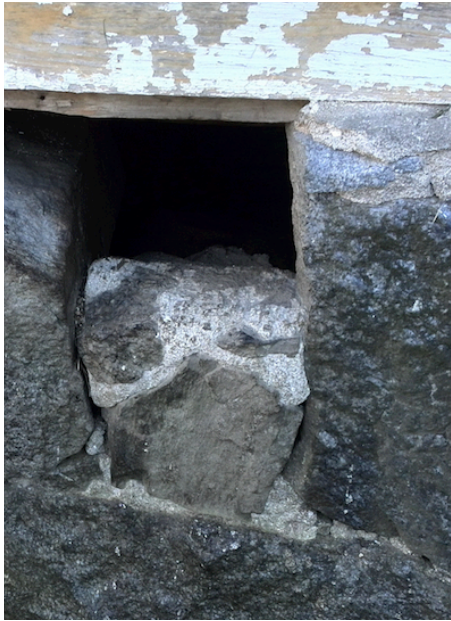
Kuva 9. Alapohjan tuuletusaukko
