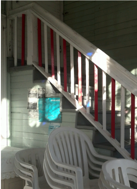
Kuva 31. Vinttitilaan nousevat portaat
