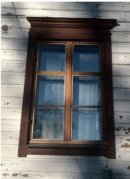
Kuva 17. 1980-luvulla uusittu ikkuna
