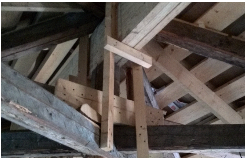
Kuva 13. Kurkihirsirakenne ja kattotuolit
