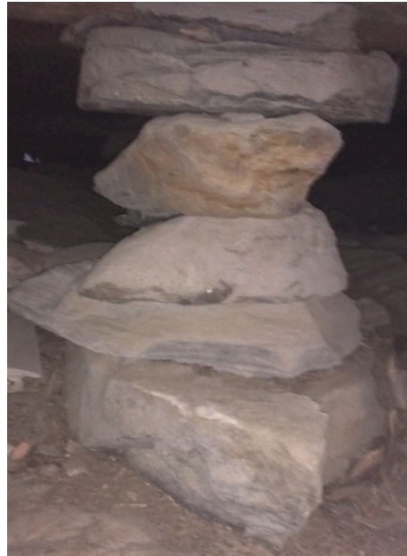
Kuva 10. Alapohjaa kannatteleva kivipilari
