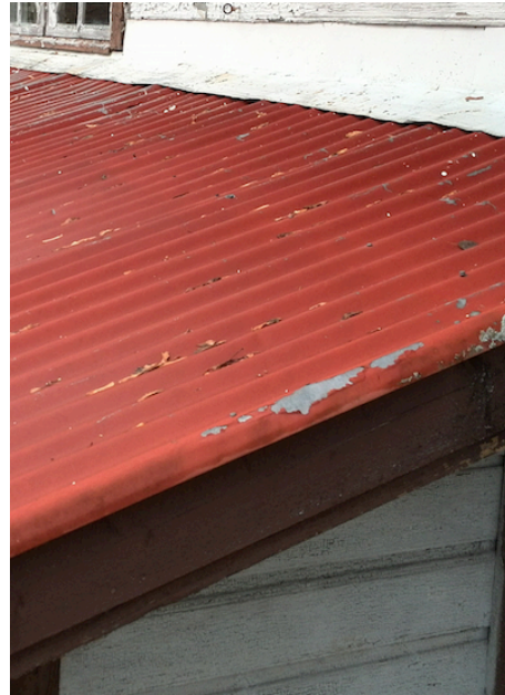
Kuva 25. Peltikatteen maalivaurio
