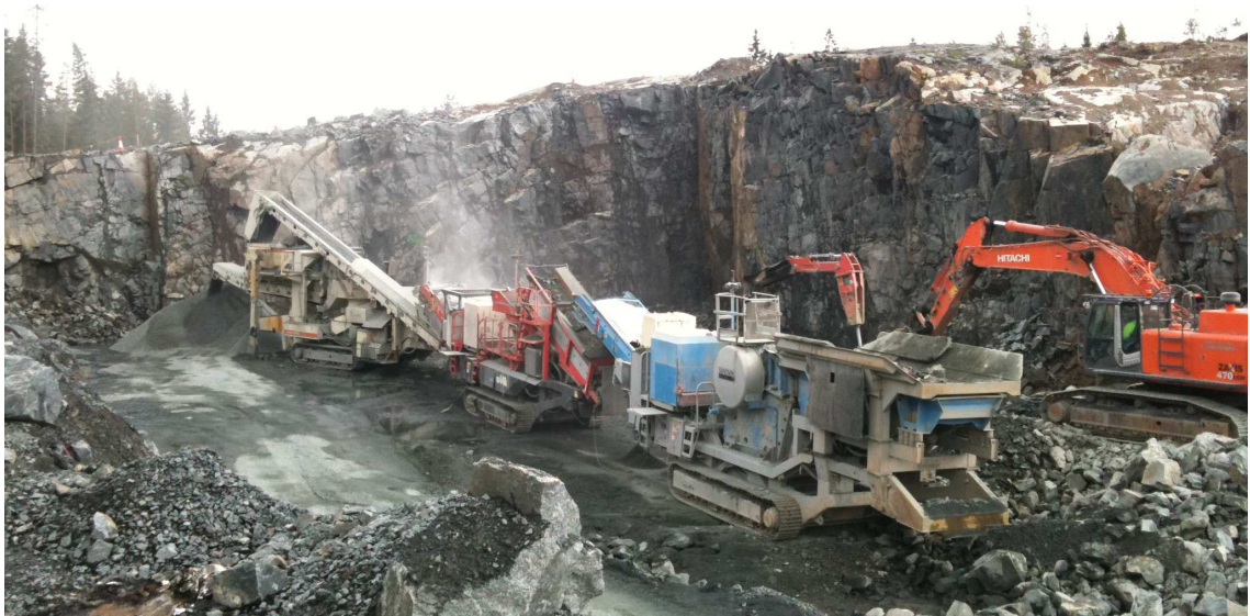
KUVA 16. Kolmivaiheinen mobiilimurskauslaitos [kuva Olli Aalto 2010]
