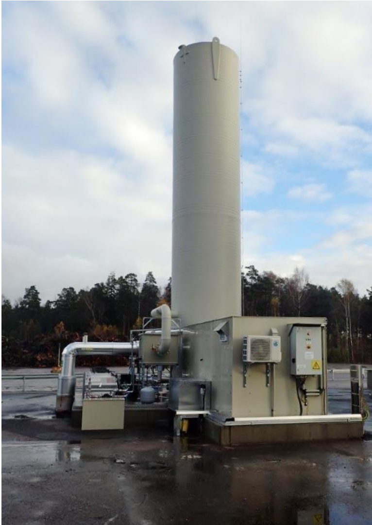
Kuvio 5. Rikinpoistosarake, biokaasun rikinpoisto. (Rousu 2015.)
