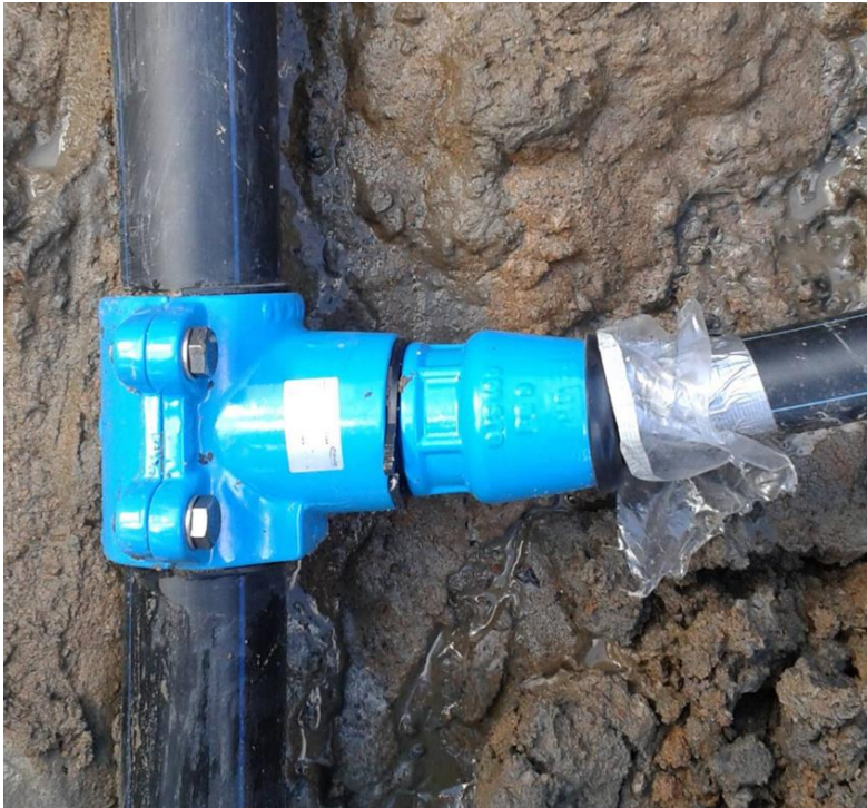
KUVA 16. Väliaikaisen vesijohdon liitos päävesijohtoon
