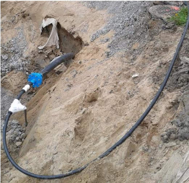
KUVA 21. Väliaikaisen vesijohdon liitos palopostiin
