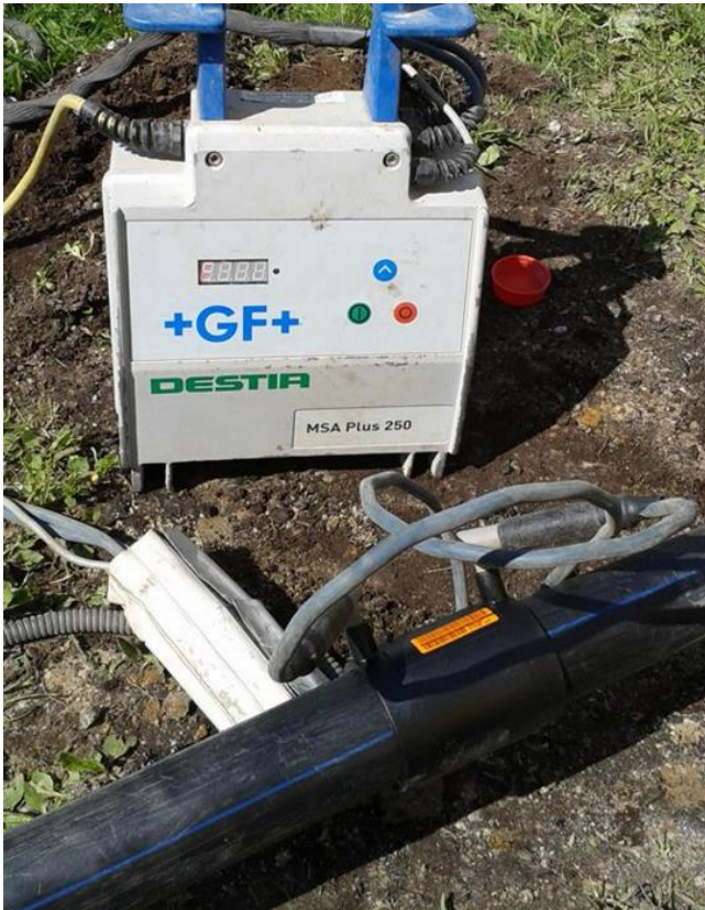
KUVA 19. Vesijohdon sähkömuhvihitsaus
