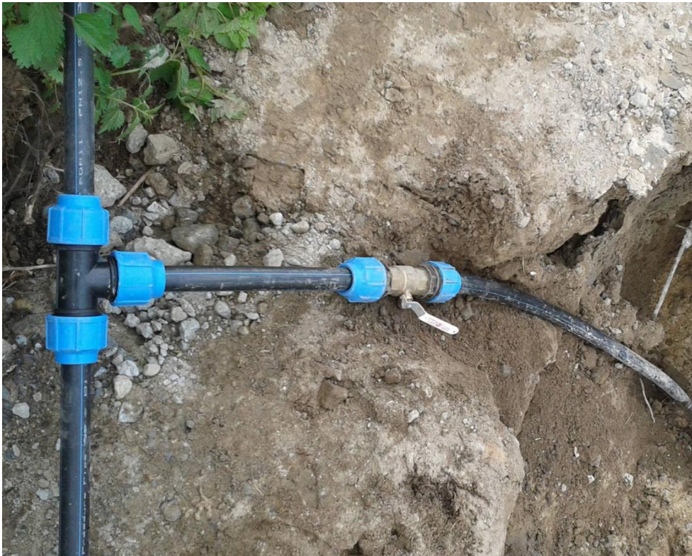
KUVA 17. Väliaikaisen vesijohdon liitos tonttijohtoon
