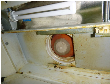
KUVA 8. Liesituulettimen tulppaus. KUVA 9. Venttiilien teippaus.
