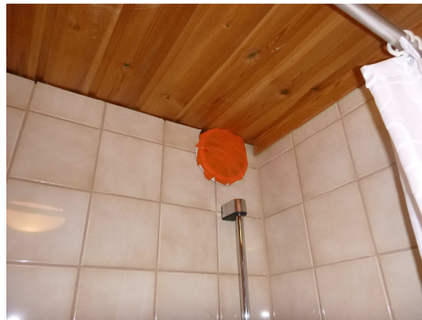
KUVA 8. Liesituulettimen tulppaus. KUVA 9. Venttiilien teippaus.
