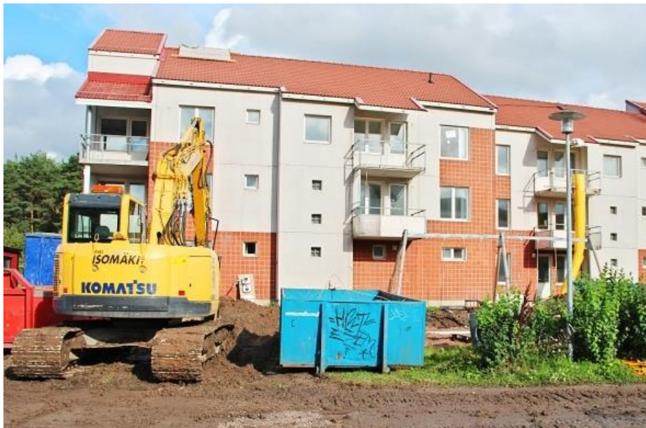
Kuva 1. TYS Haliskylän työmaa.
