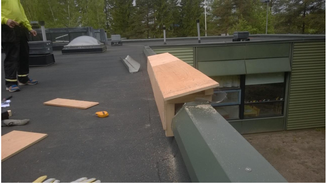
Kuva 1. Tuulettuvan räystäsrakenteen mallityö.
