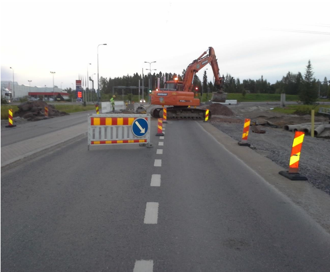
KUVA 7. Työskentelyä ajoväylällä, valmistavien työvaiheiden tekoa ja liikenneohjauksen järjestämistä liikenneportaalin nostoa varten
