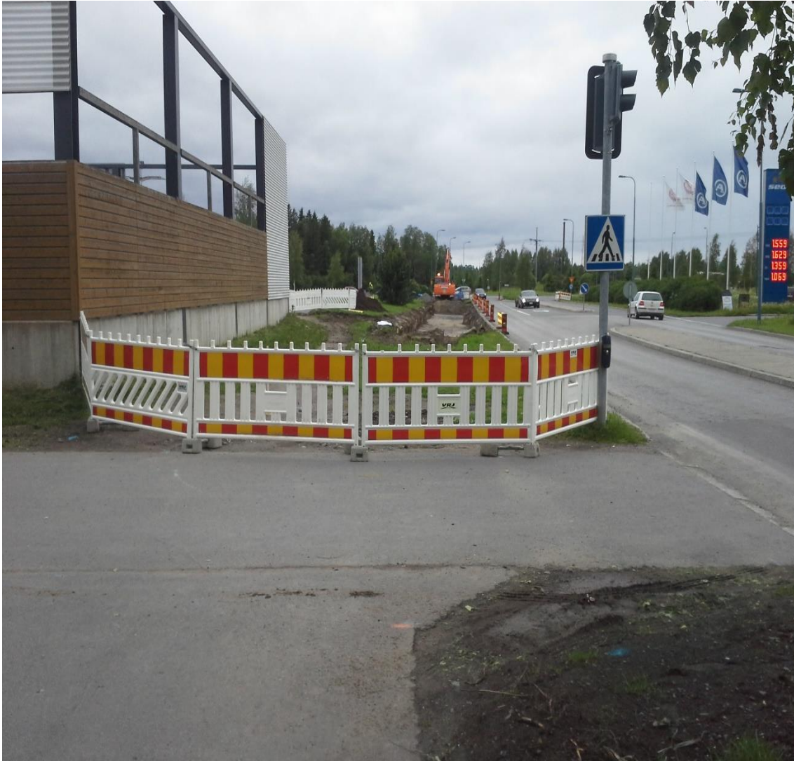
KUVA 5. Kevyen liikenteen väylän rakentaminen ja kulun esto työmaalle
