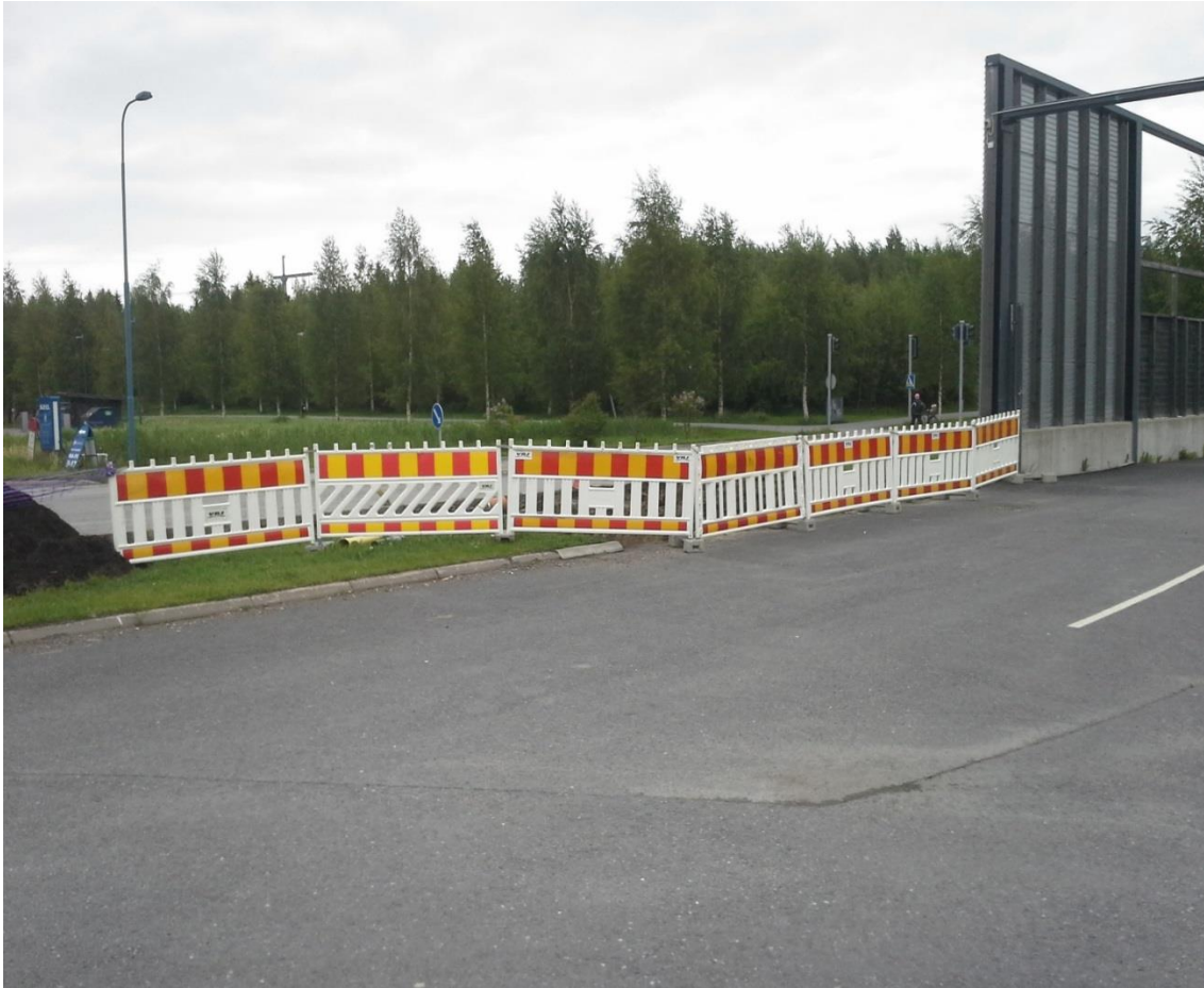
KUVA 6. Kevyen liikenteen väylän rakentaminen ja kulun esto työmaalle
