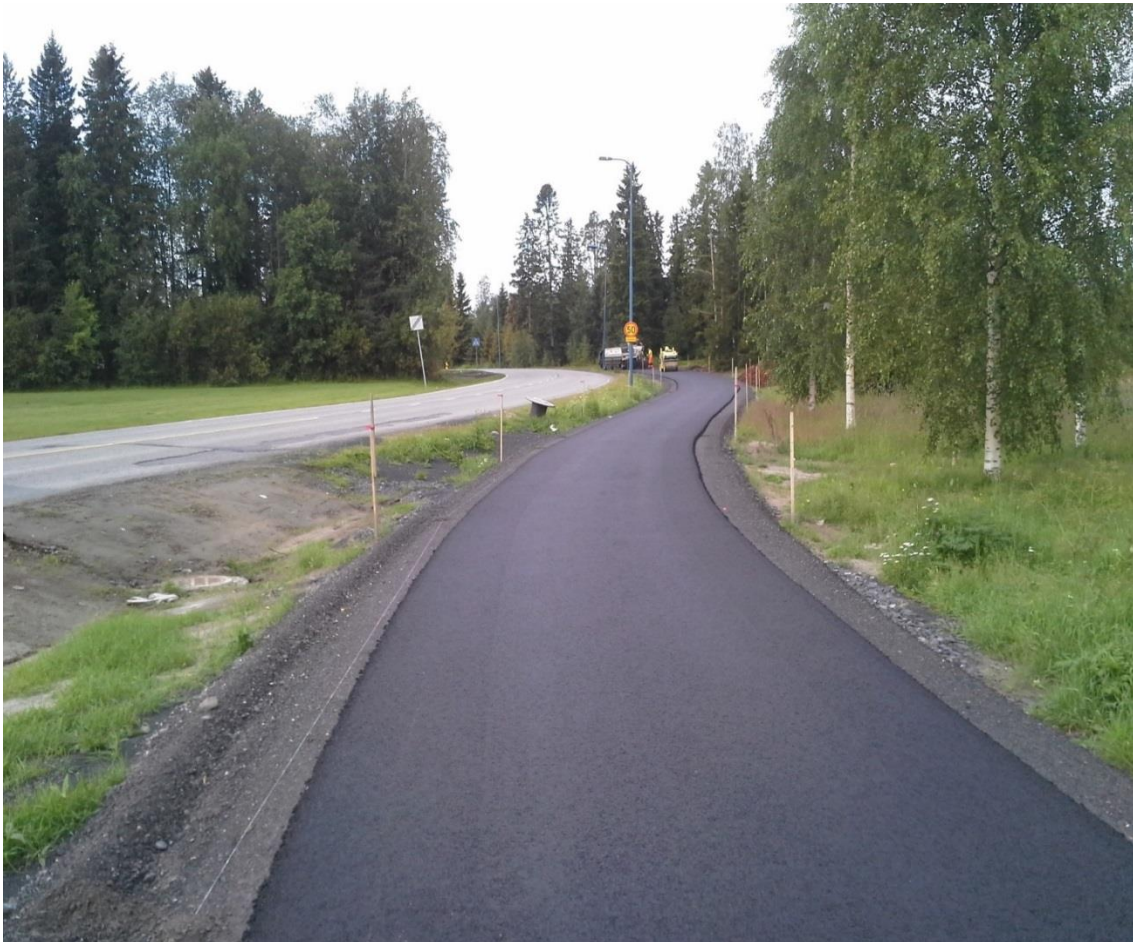
KUVA 9. Uusi kevyenliikenteen väylä valmistunut Metsokankaantien vierelle
