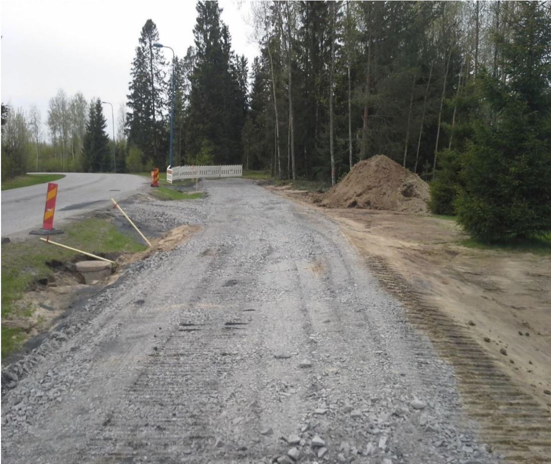
KUVA 2. Työaikainen liittymä työmaa-ajoa varten
