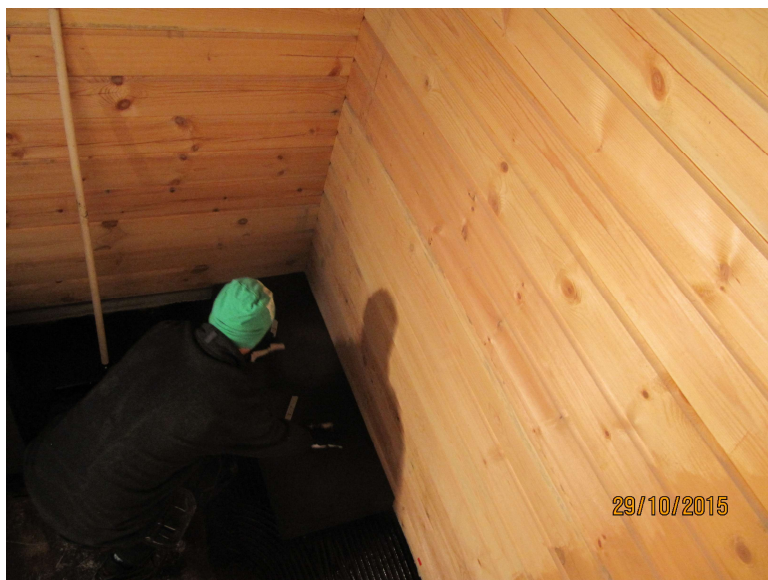
Kuva 21, Ensimmäisten laattojen asennus
