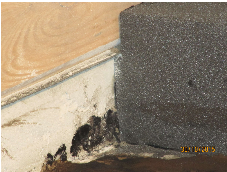
Kuva 17, Solulasilaatta on lovettu ja kiinniliimattu
