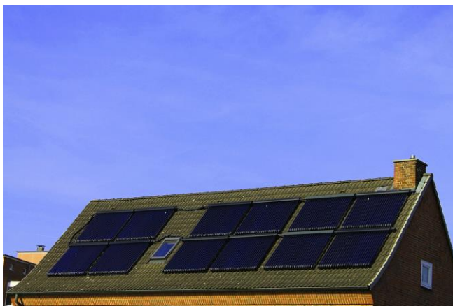
Kuva 3. Aurinkopaneelisto asennettuna pientalon katolle
