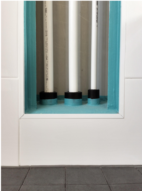
Kuva. 10 Moduulin M32 vesijohtokoteloinnin vedeneristys ja korotusvalu (5)
