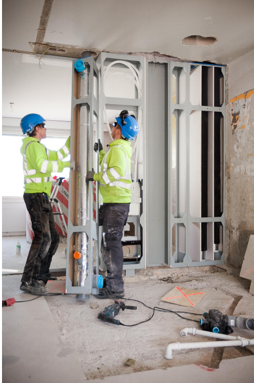
Kuva 8. M24:n asennus työmaalla (5)
