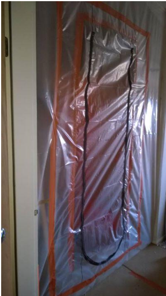
Kuva 4. Suojaseinä, missä on vetoketju-ovi. [20]
