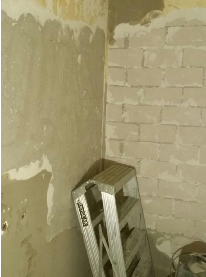
Kuva 5. Meneillään on seinien hiontavaihe.
