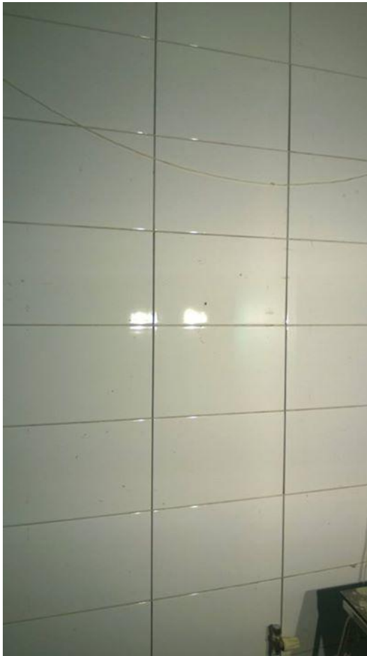
Kuva 8. Seinän laatoitustyö [20]
