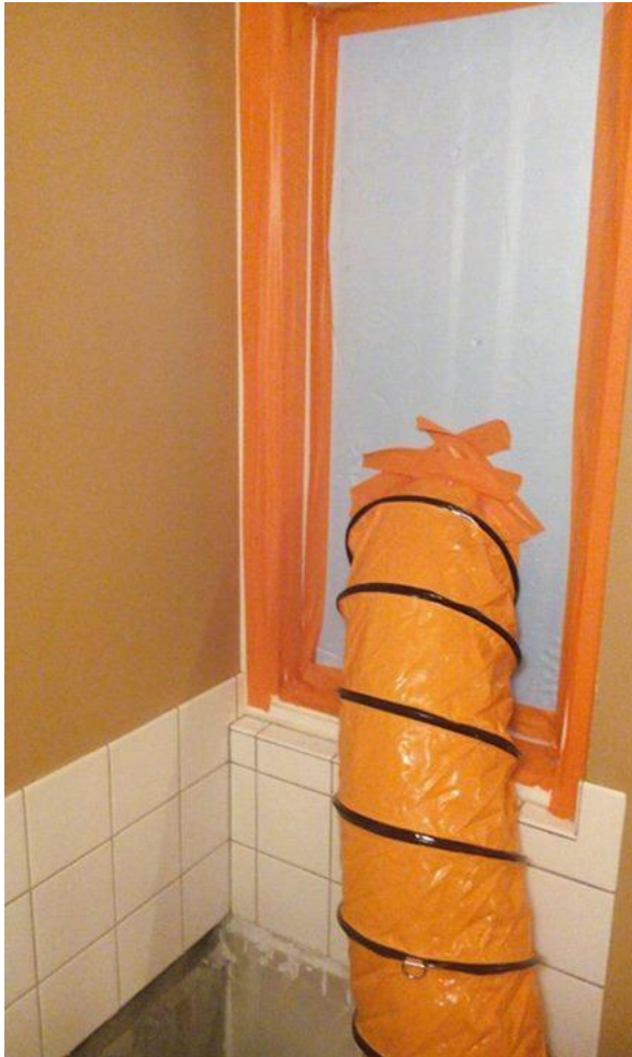
Kuva 3. Alipaineistajan poistoletku on vedetty ulos ikkunasta.
