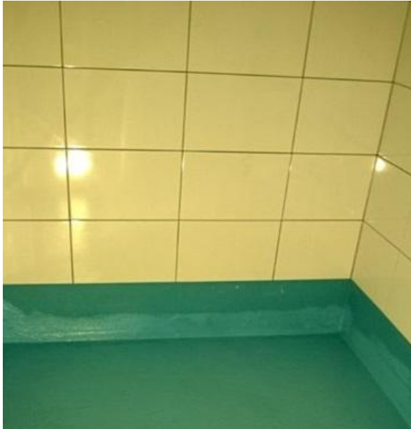
Kuva 10, Lattian vedeneristäminen [20]
