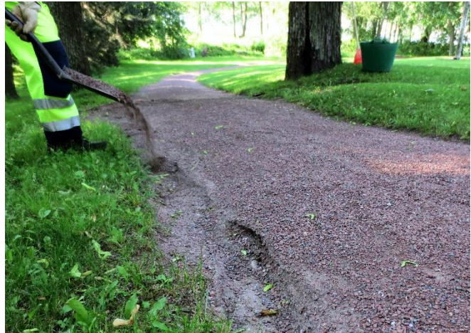
Kuva 7. Strömsin kartano: Sadekelillä muodostuneiden vesiurien paikkauksessa rinteän alaosaan valunut kivituhka palautetaan takaisin rinteän yläpäähän.
