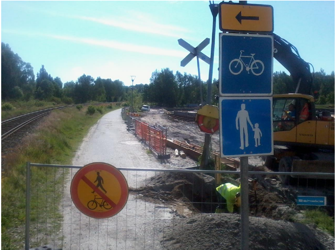
Kuva 4. Liikenteenohjaus sulkuaidoin ja liikennemerkkein, myöhemmin myös kuvassa näkyvä kaivanto aidattiin erikseen.
