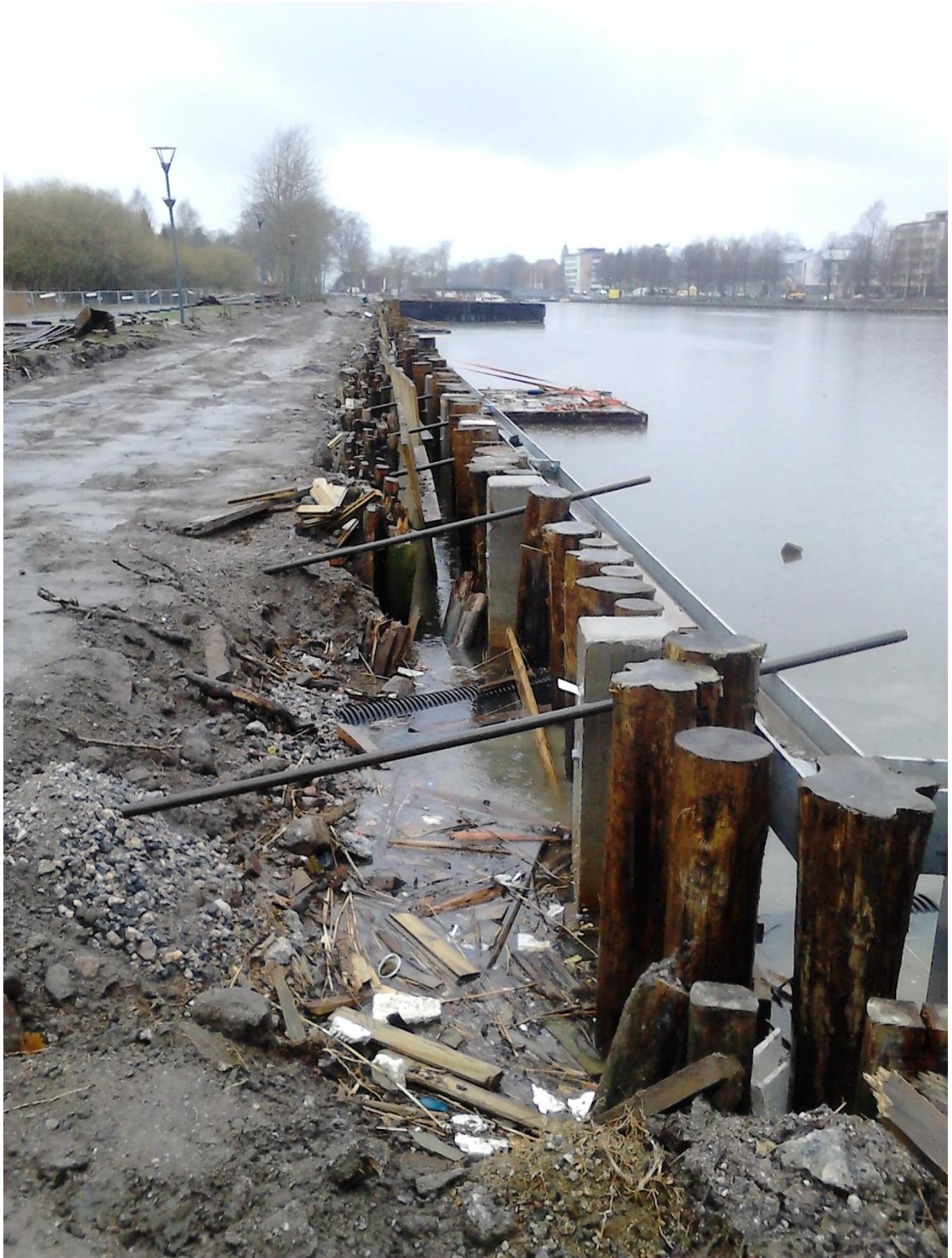
Kuva 3. Uusi paaluseinä lyötynä, ankkuritangot hitsausta vaille ja HEB240-palkki asennettuna.
