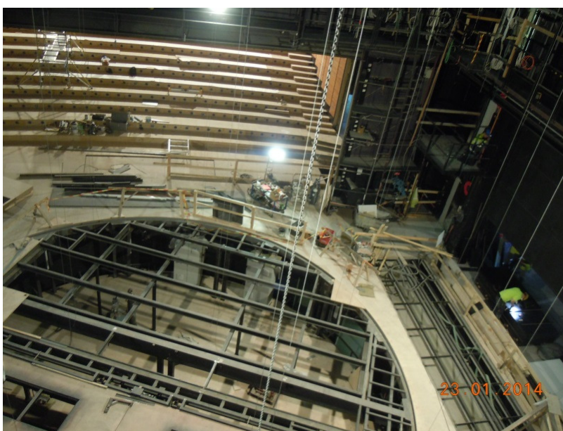
Kuva 8 , Kuopion kaupunginteatterin suuren näyttämön pyörönäyttämö. Sen takana vasemmalla näkyy katsomo, jossa ei ole vielä penkkejä. Kuvan keskivaiheilla näyttämöaukko rajautuu portaalitorniin. Sen rakenteissa erottuu kerrokset. Portaalitornin oikealla puolella on parvelle nostettu mekaniikan ohjauspiste.
