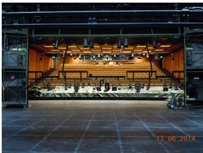
Kuva 5 , Kuopion kt:n suuren näyttämön näyttämöaukko. Sivuille portaalitornit, yläpuolella portaalisisiltä. Etunäyttämöllä näkyy alas laskettu valonostin.
