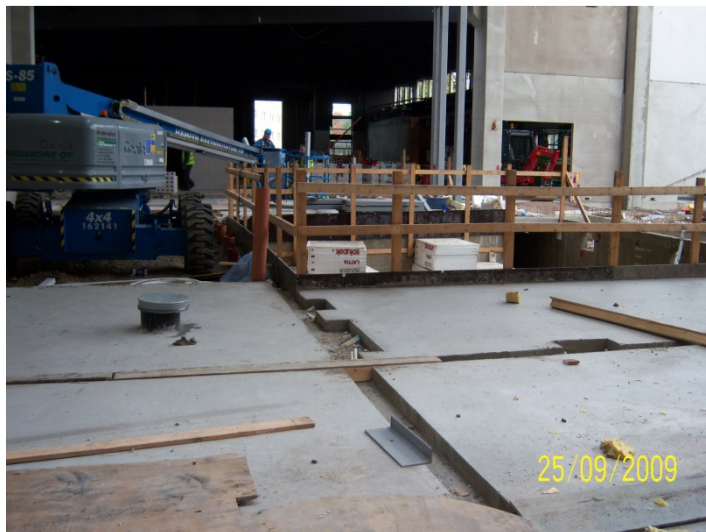
Kuva 6, Hämeenlinnan kaupunginteatterin näyttämön lattialuukut ja rottametro valun jälkeen.
