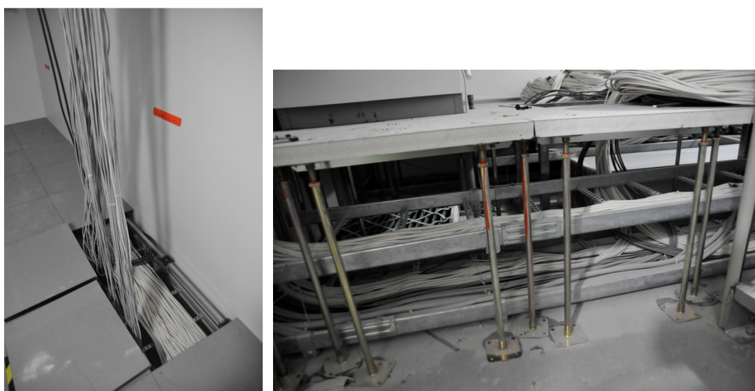
Kuva 20, Asennuslattioita Musiikkitalolla
