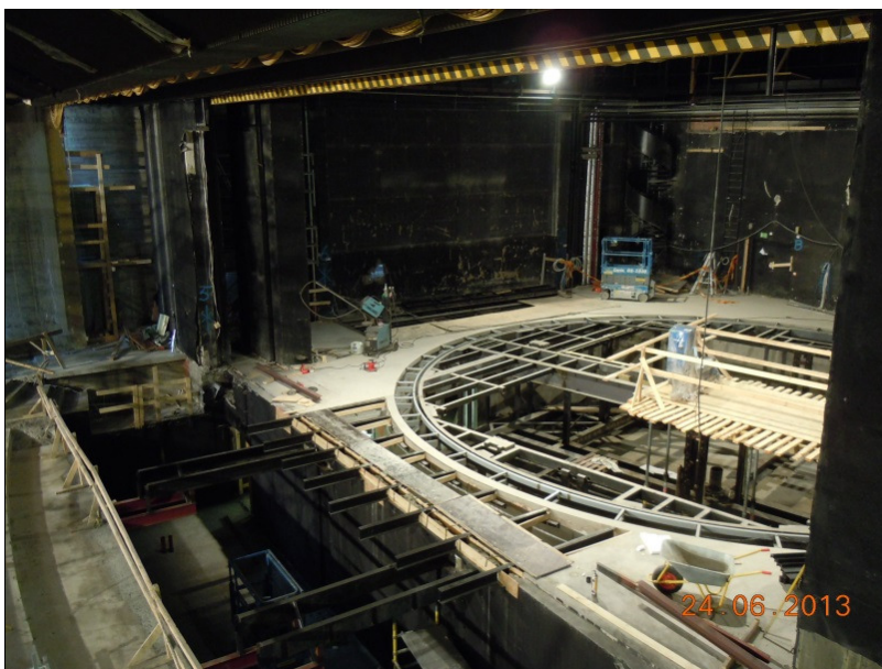
Kuva 7 , Kuopion kaupunginteatterin suuri näyttämö noin vuosi ennen vastaanottoa. Vasemmalla etualalla on monttu, johon myöhemmin asennetaan rinnakkain kolme orkesterinostinta. Näyttämö aukon takana oikealla puolen näkyy pyörönäyttämön rakenne, jonka pinnasta puuttuu vielä kansirakenne.
