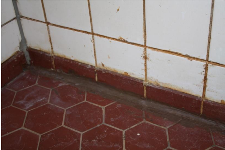
Kuva 15 Erään pesuhuoneen suihkutila
