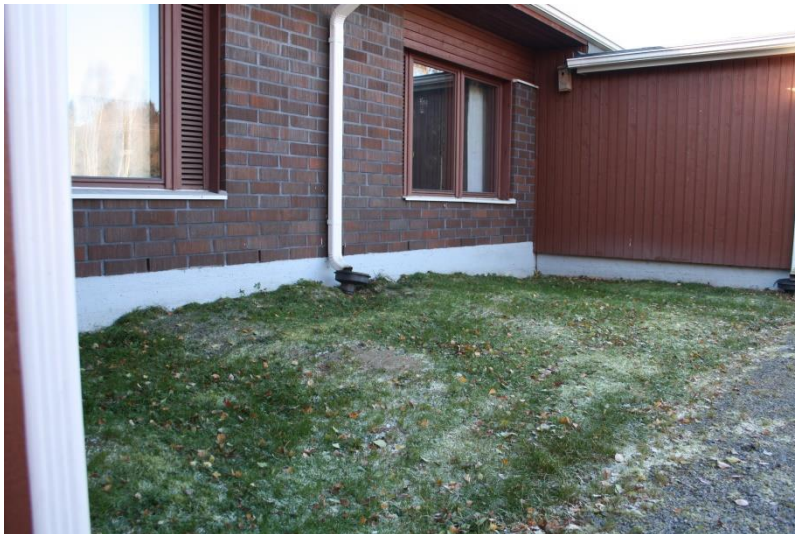
Kuva 2. Sokkelin ulkopuolisen maanpinnan korkeus.
