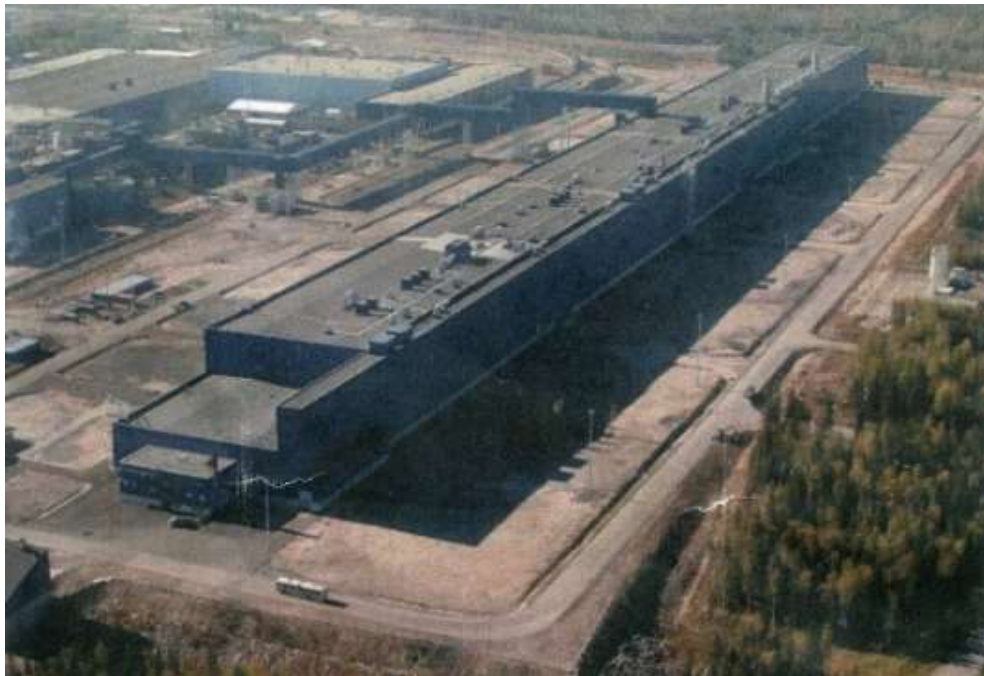
Kuva 2. RAP5 on noin 800m pitkä rakennus ja linjalle mahtuu nauhaa 5 kilometriä (Outokumpu Oyj 2006.)
