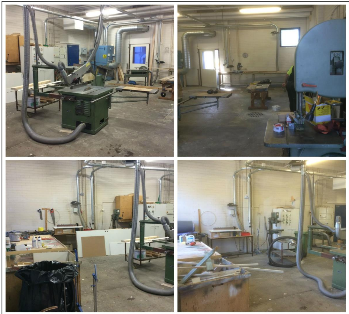
Kuva 4. Puutyöverstas. Vasemmalla olevat kuvat ennen ja oikealla jälkeen.
