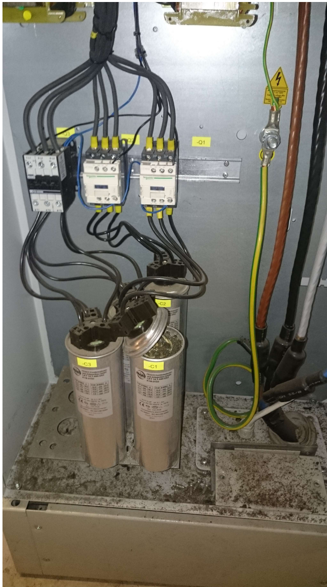
KUVA 3. Kompostointilaitoksen kompensointilaitteisto
