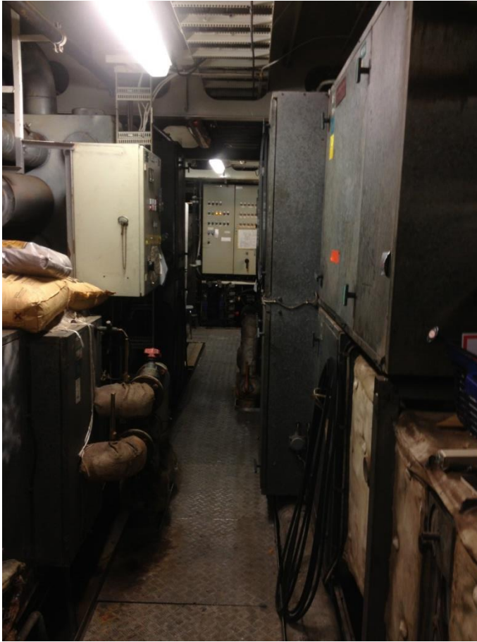
Kuva 2. Kuva ilmastointihuoneen sisältä
