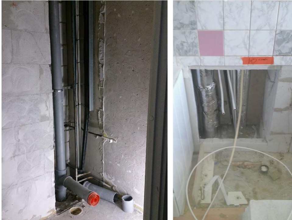
Kuva 7. Avattu hormi kylpyhuoneessa ja keittiössä.
