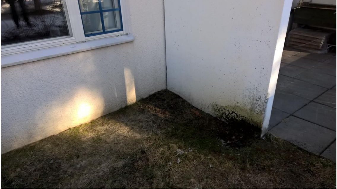
Kuva 5 Maanpinta ylittää sokkelin yli elementin reunaan asti. Parvekkeenpieli kärsii huonosti johdetuista sadevesistä.
