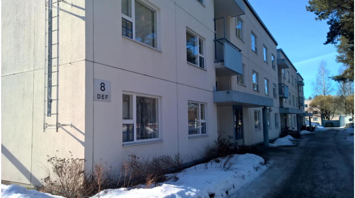
Kuva 1 Kohteen julkisivu pohjoiseen.
