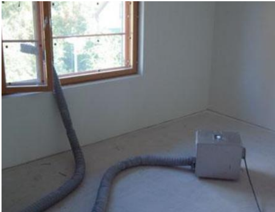
Kuva 15. Kuivain rakennuksessa runkovaiheen aikana. Kosteaa ilmaa poistuu letkua pitkin ulos. (Hengitysliitto n.d.)
