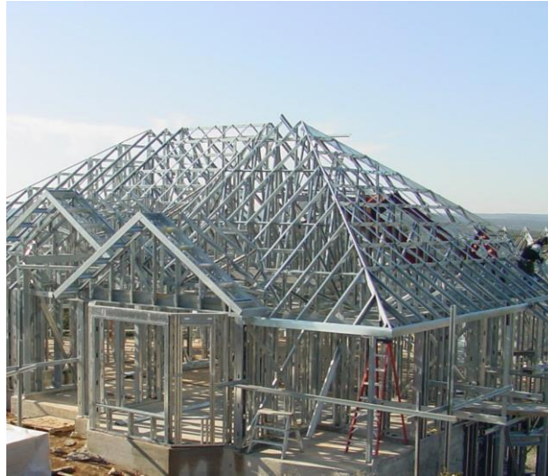
Kuva 6. Teräsrankarunkoinen pientalo, runkorakenteet valmiina (Steel frame housing n.d.).
