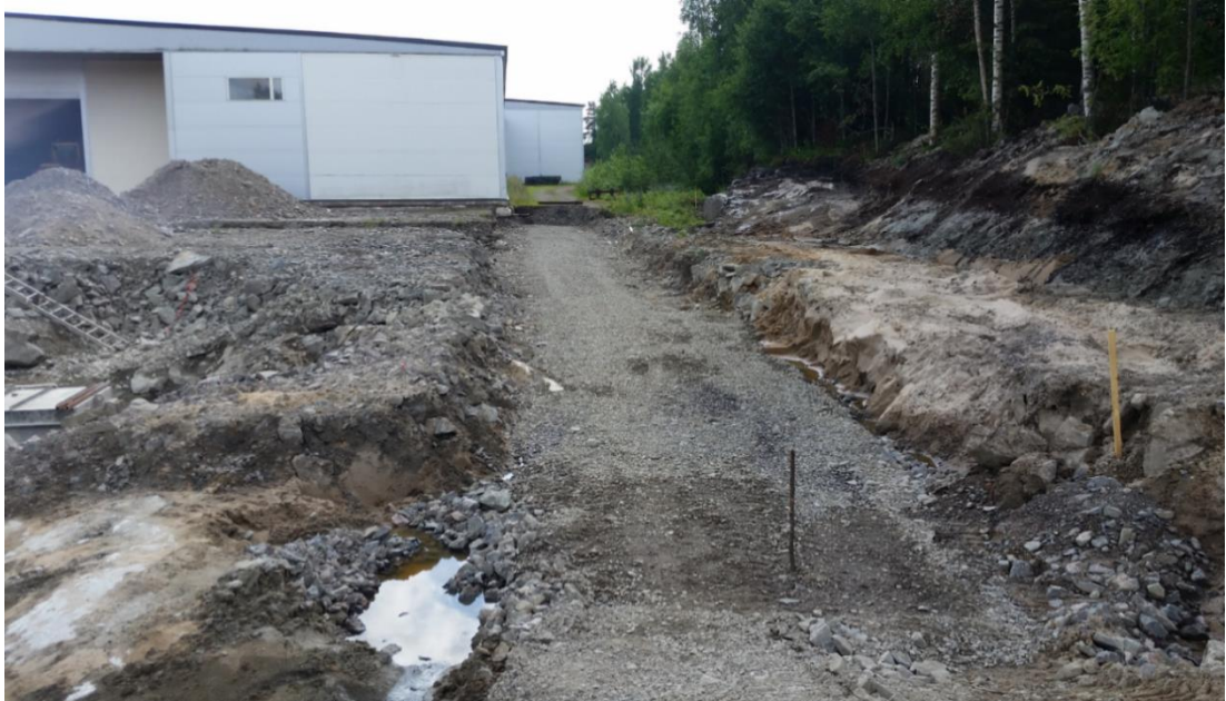
Kuvio 28. Hallin laajennusosan perustuksien rakennusvaihe
