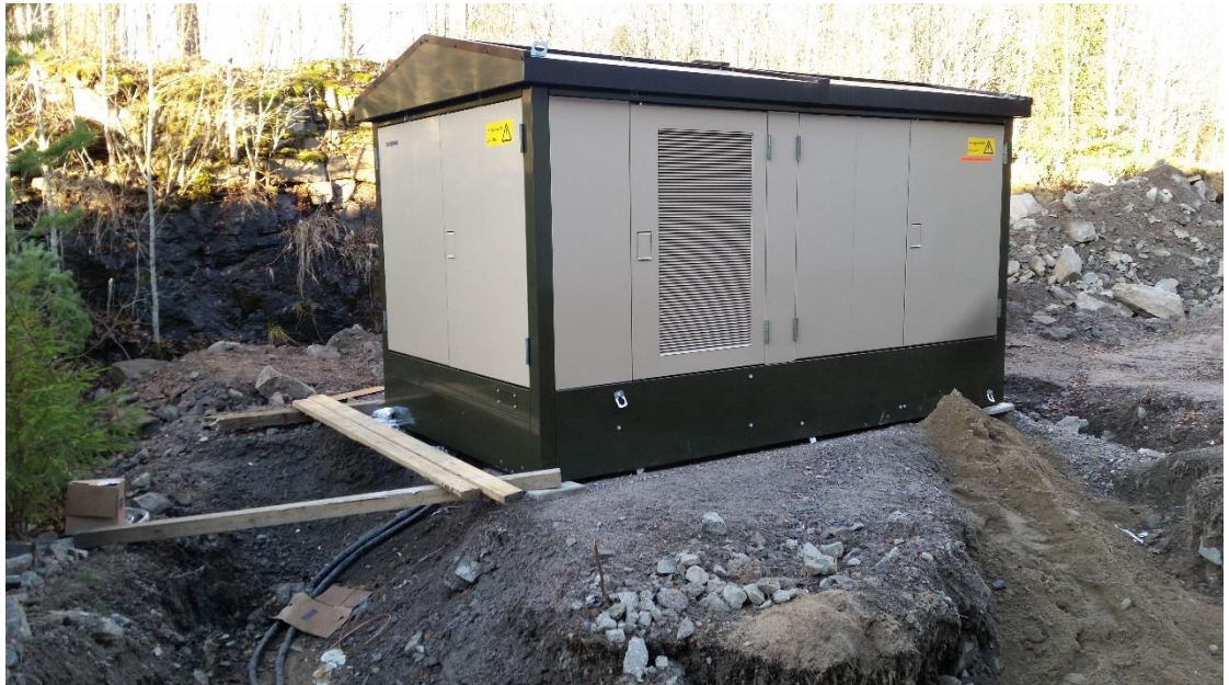
Kuvio 31. Puistomuuntamo asennettuna työmaan rakennusvaiheessa
