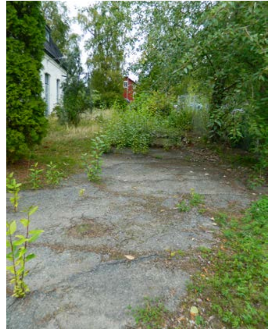
Vanha asfaltti puretaan rakennekerroksineen. Samalla katoaa suurin osa juurivesoista ja muista ei-toivotuista puuntaimista.
