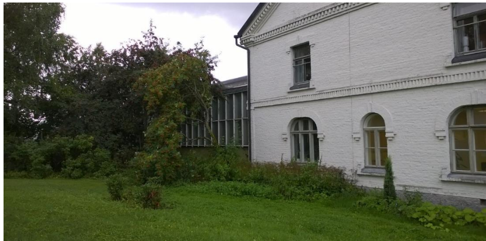
Kuva 6. Päärakennuksen pohjoisseinusta elokuu 2014
