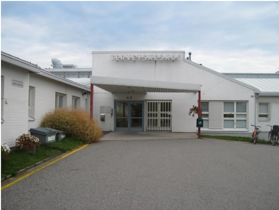
KUVA 1. Haukiputaan terveysasema, pääsisäänkäynti (Kuntoarvio Haukiputaan terveyskeskus ja Simppulan kartano. 2010)
