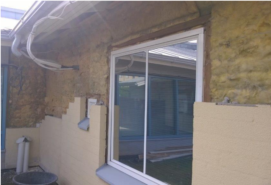
KUVA 4. Vaurioituneen seinän purku aloitettu
