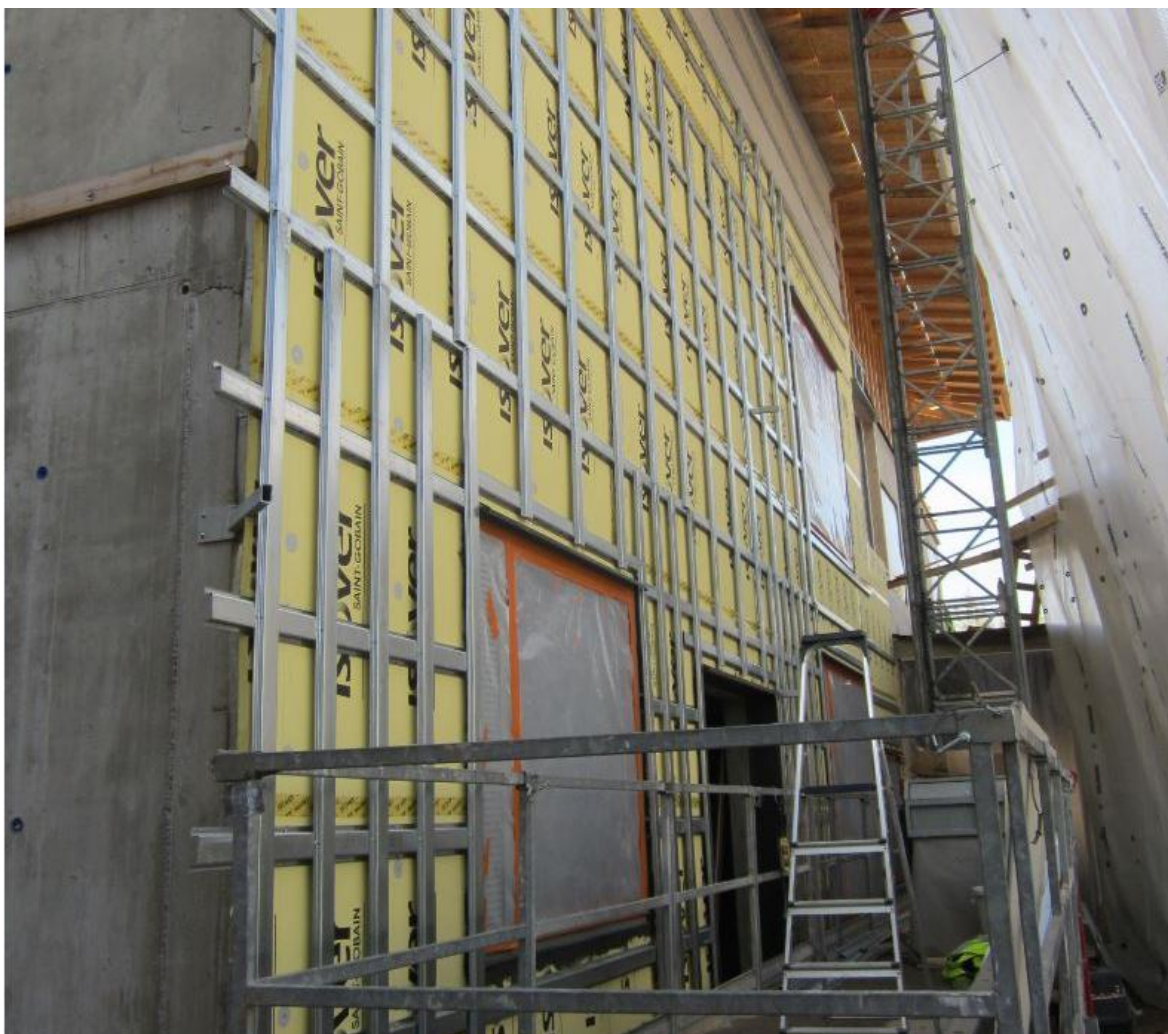
Figur 9. Bild från Storby allaktivitetshus, på bilden kan man se de stående hattprofilernas c/c avstånd som är tätare de första 2,4 metrarna mätt från sockeln uppåt.
