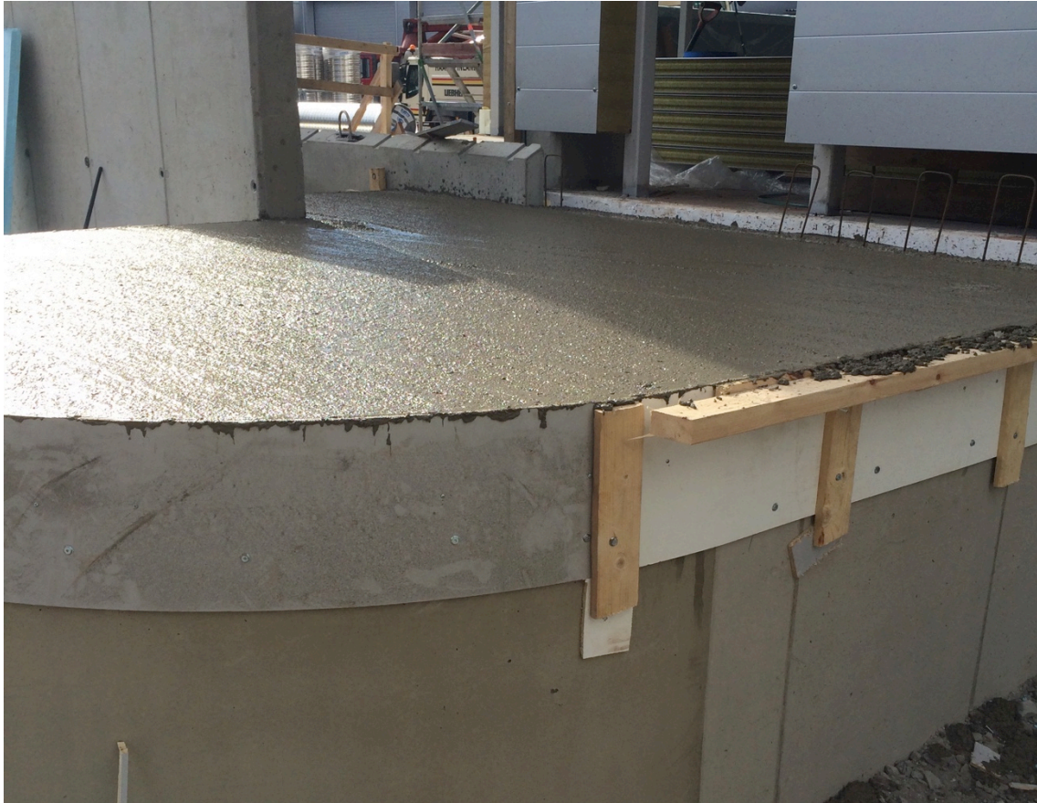
KUVA 14. Betonilaatan pinta johon teräskierreporras kiinnitetään
