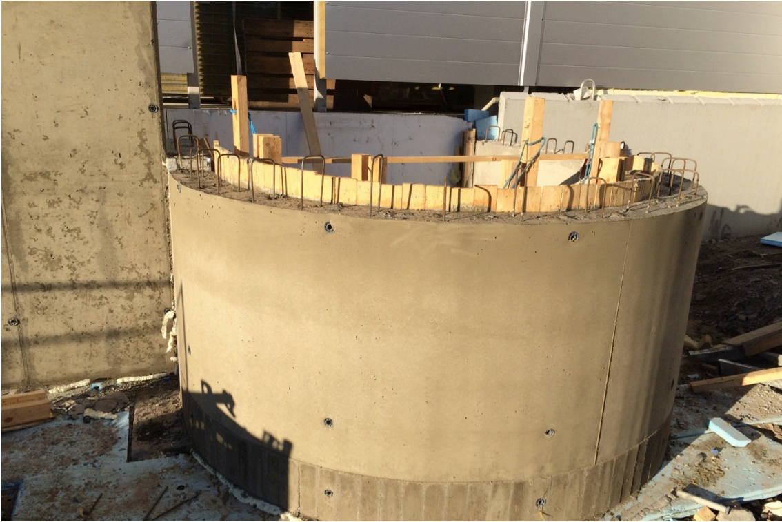
KUVA 13. Portaan perustan kaareva osa ilman muottia
