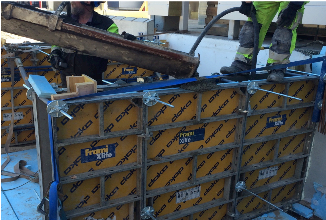
KUVA 11. Betonointi suoritettiin kouruvaluna betonikuljetusautosta
