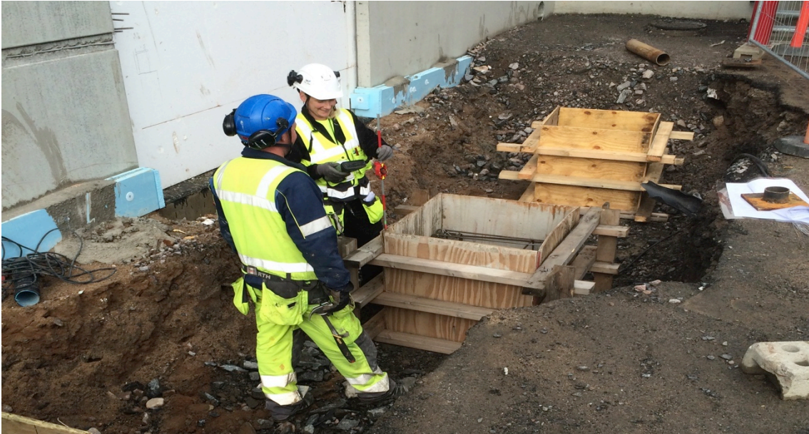
KUVA 10. Anturamuotin sijainnin paikannus takymetrimittalaitteen avulla
