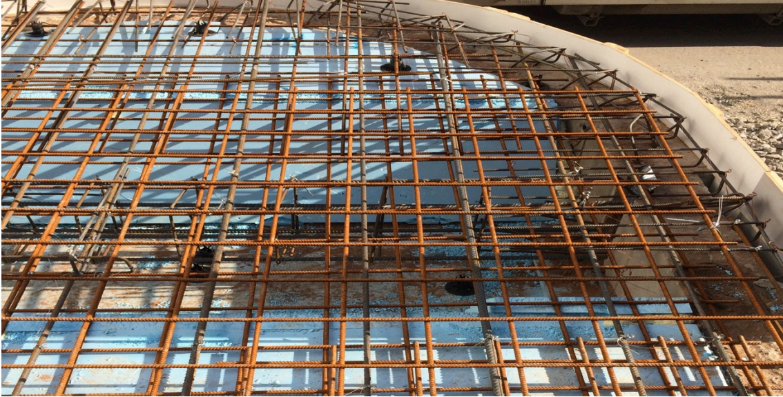
KUVA 12. Porrasperustan raudoitus tehtiin muottien väliin
