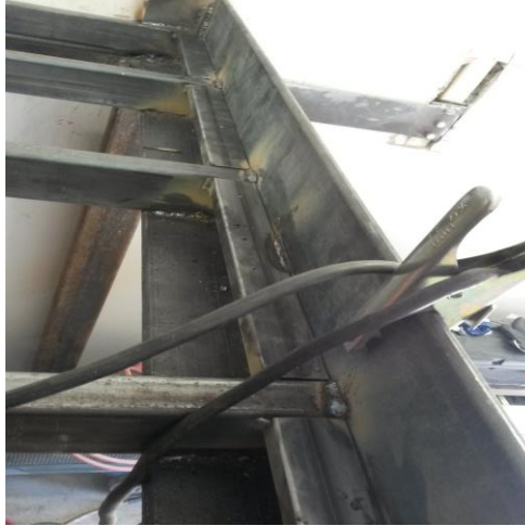
Kuva 38. Lattian kannatuspalkkien ja L-palkin liitokset.
