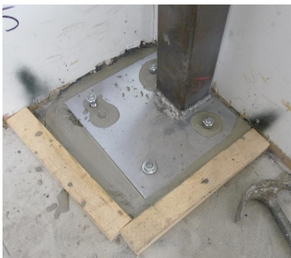
Kuva 34. Pilareiden juottaminen juotosbetonilla. Kiila-ankkurit isketty paikoilleen.
