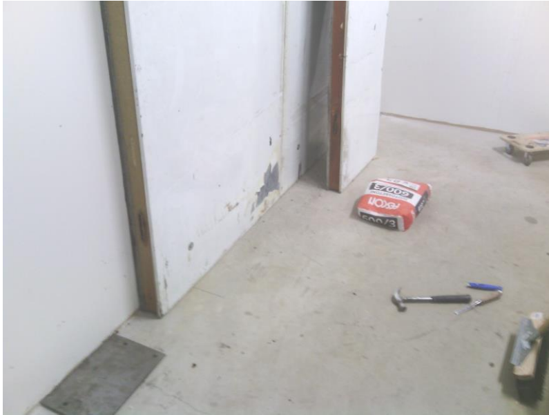
Kuva 29. Aluslevyjen asettelua.
