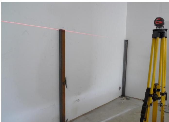
Kuva 32. Takimmaisten tukipilareiden keskitäminen tasolaserin avulla.
