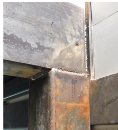
Kuva 35 Etupilarin seinäkiinnikkeen liitos edestä.
