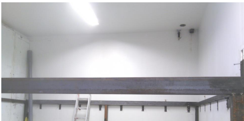
Kuva 37. Etummainen L-palkki ”heftattu” tukipilareihin.
