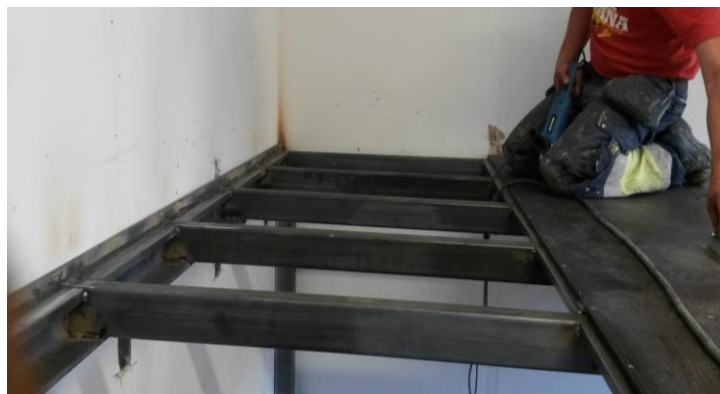
Kuva 39. Lattian liittäminen. Lattia liitettiin kannatintukipalkkeihin itseporautuvilla ruuveilla ja liimamassalla.
