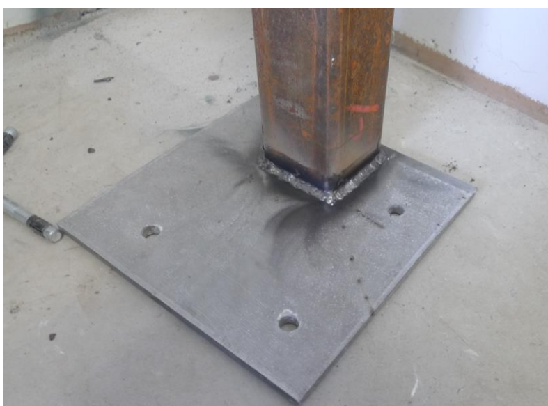
Kuva 33. Liitetty pilari ja aluslevy.
