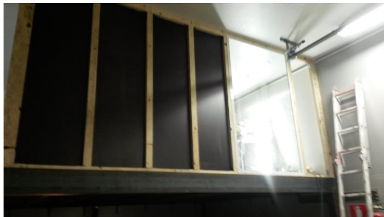
Kuva 41. Parven etuseinän rakenne.
