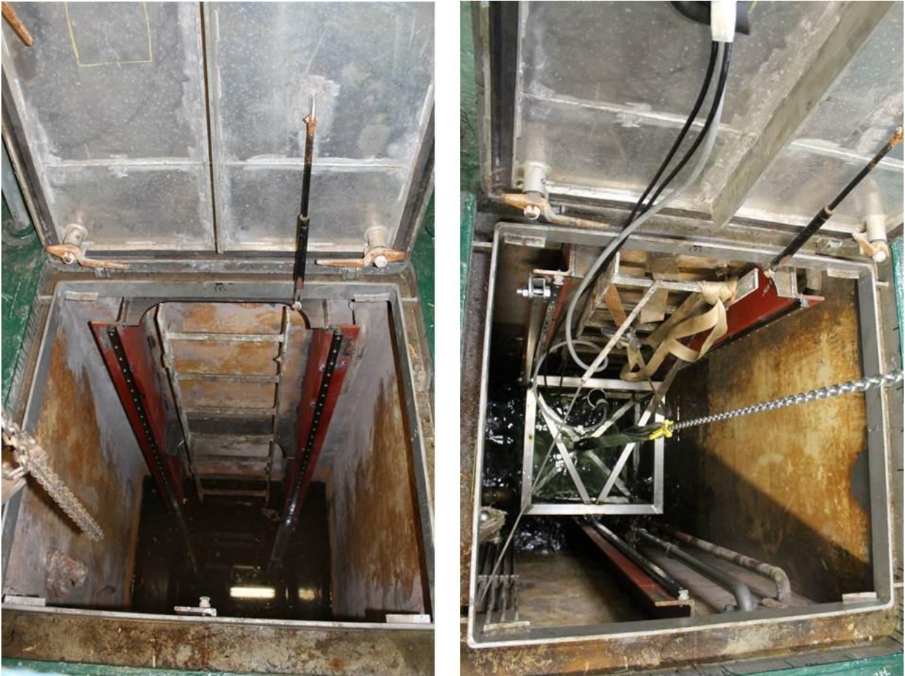
Kuva 1. Arandan ”Moon pool” ja kaikuluotaimen anturin asennusta.
