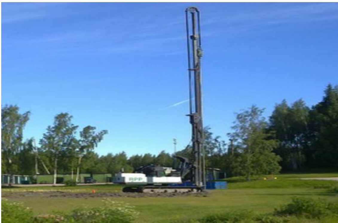
Kuva 1. Stabilointikone (Rakentajat Piippo & Pakarinen 2014).
