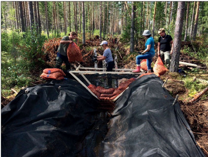
KUVA 1. Hakesuodatin rakennusvaiheessa (Juva, Paatela). Hake pakattu verkkosäkkeihin, jotka ladotaan niitä varten rakennettuun kehikkoon (kuva Kalle Karosto)
