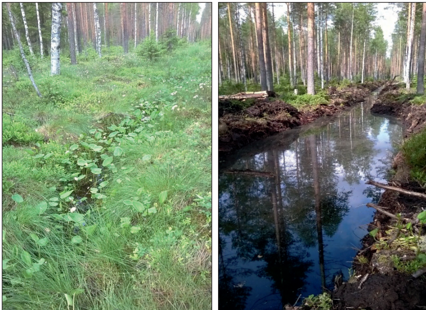
KUVA 1. Kunnostusojituskohde ennen kaivutöitä ja niiden jälkeen (kuvat Tuija Ranta-Korhonen)
