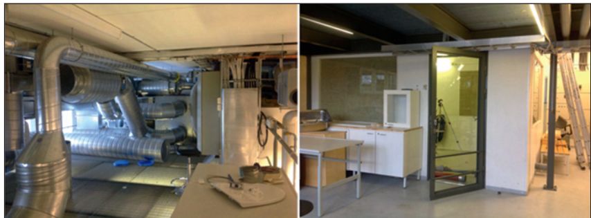
KUVA 2. Vanhat laboratoriolaitteistot ja tilat odottavat purkamista (kuvat Johanna Arola)
