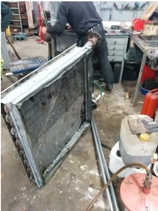
Figur 8. Täthetskontroll och rengöring av värmeväxlare. Fotograf Max Nybondas. Västanfjärd 2015.
