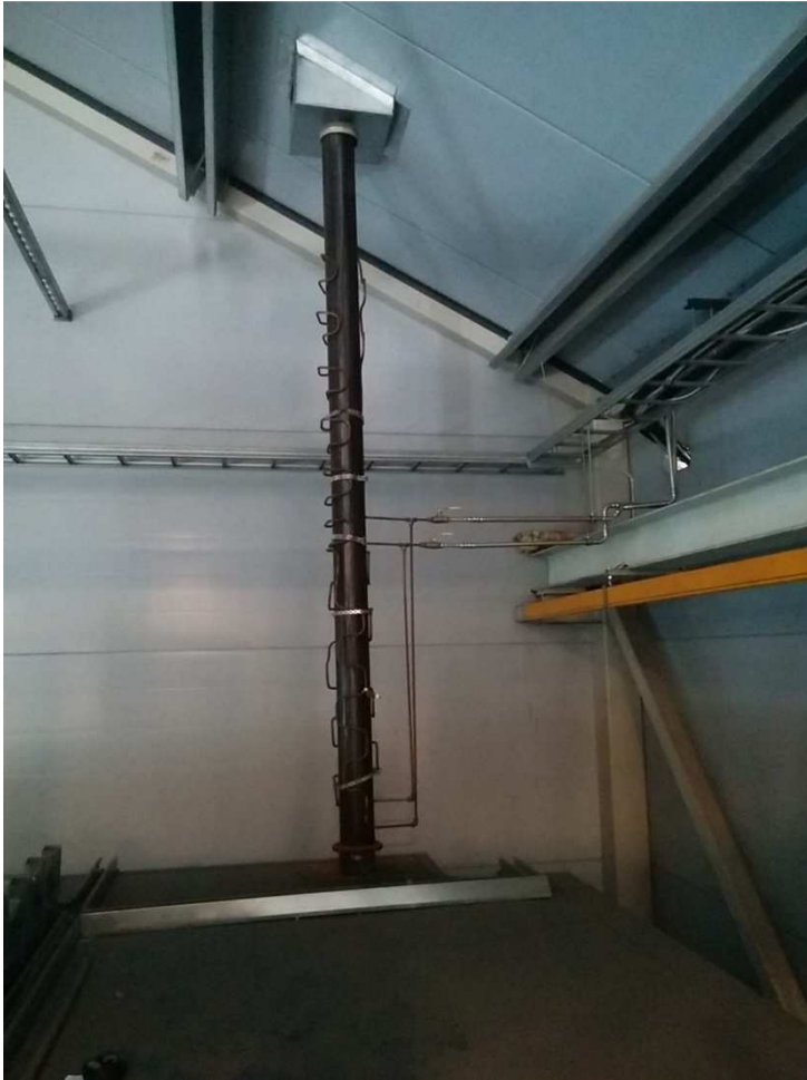
Figur 10. Torkningsugnsens pipa i stål. En plan för värmeåtervinning har någon gång funnits, men aldrig fullföljts. Fotograf Max Nybondas. Västanfjärd 2015.
