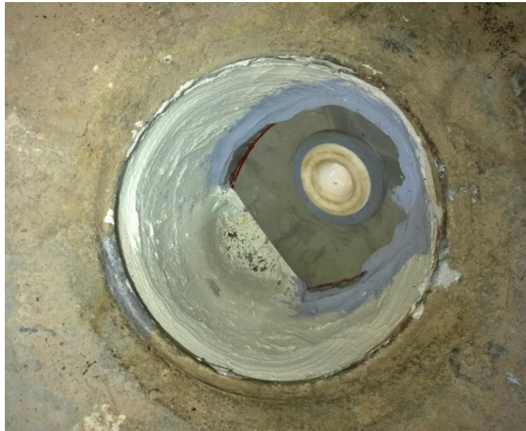
Kuva 17. Valmis lattiakaivo, jossa uusi ruostumattomasta teräksestä valmistettu hajulevy ja uusi puhdistustulppa. (Kuva Newliner työmaalta 7.4 2015 Kuvaaja: Mikko Lehto
