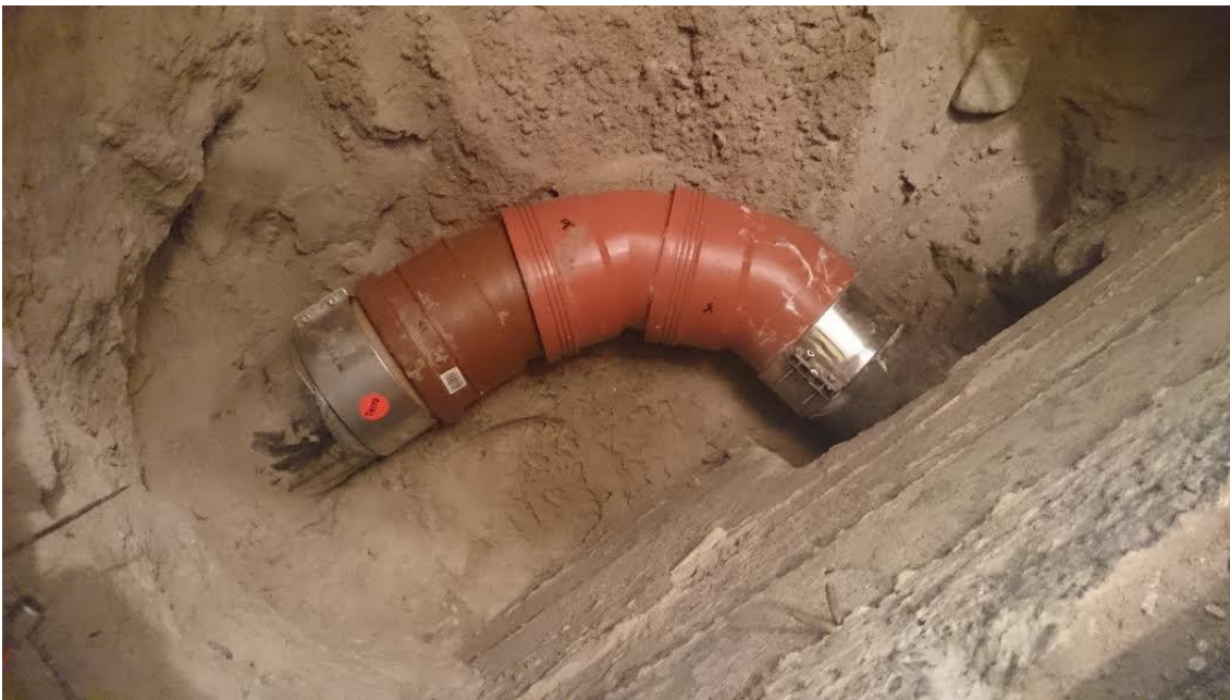
Kuva 7 Työkaivanto, jossa runkoviemäri tekee tiukan mutkan. viemäriosuus uusittu uudella PVC viemäriputkella, sukitustöiden valmistuttua. (Kuva Hyvinkäältä Newliner työmaalta 12.8.2014 Kuvaaja: Niklas Sinisalo)
