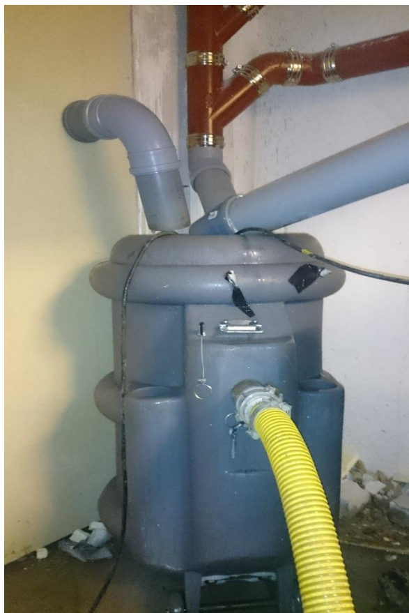
Kuva 8 Väliaikaisviemäröinnin pumppaamo, kuvassa tuodaan 3 eri pystyviemäriä pumppaamolle harmailla PVC-putkilla. Keltaisen letkun kautta viemäriverdet pumpataan pihakaivolle (Kuva Vuosaaresta Newliner työmaalta 6.3 2015 Kuvaaja: Niklas Sinisalo)
