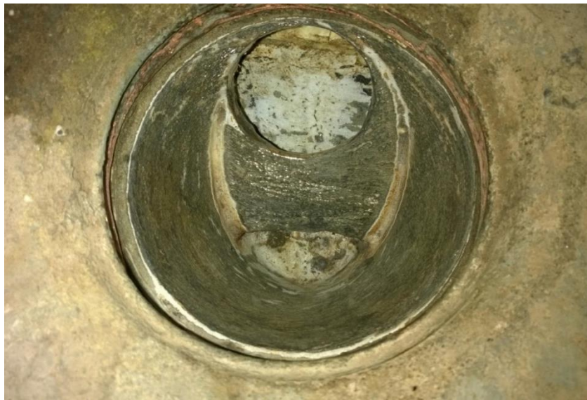
Kuva 9 Puhdistettu lattiakaivo johon on porattu huulloslevyyn reikä.. (Kuva Newliner työmaalta 7.4 2015 Kuvaaja: Mikko Lehto)
