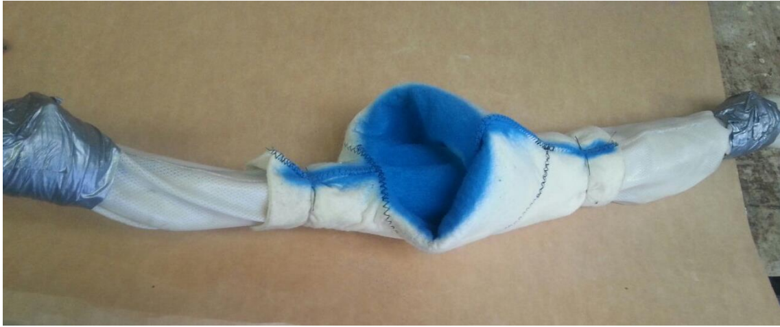
Kuva 15, Bladderin päälle pujotettu haarayhde ennen putkeen asennusta. (Valokuva Newliner Sukitus työryhmä 4 asennus kuorma-autosta, 27.2 2015 kuvaaja: Kenny Rantala
