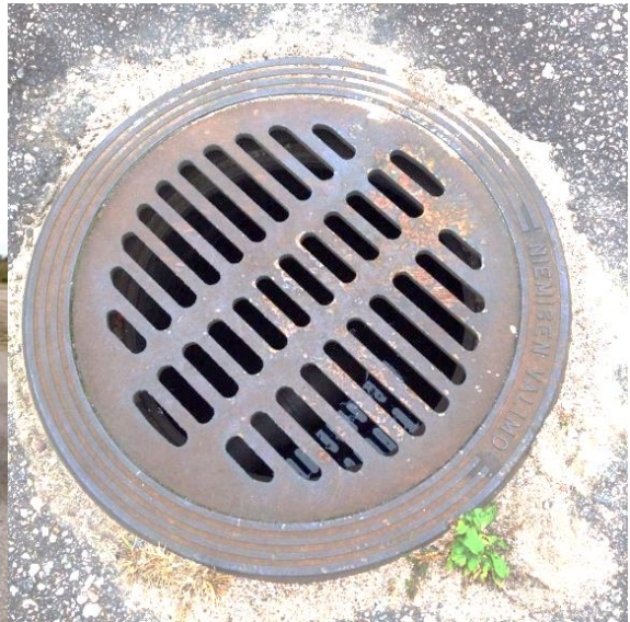
Kuva 25 Tankkauspaikkeen öljynerotuskaivo
