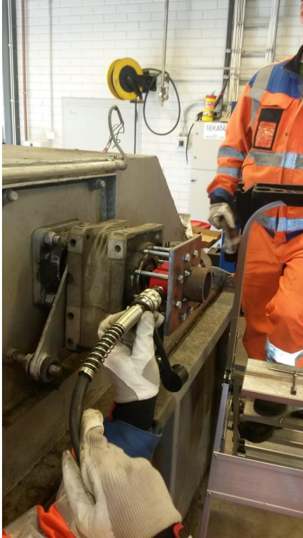
Kuva 9. Arinatuhkalavan vaihteiston irrotuksessa käytetään apuna ulosvetoon tehtyä irrotustukea.
