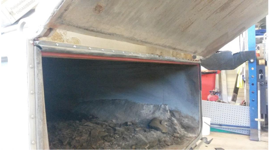
Kuva 7. Arinatuhkalava korjattuna. Lavan yläosan luukutiiviste on uusittu.
