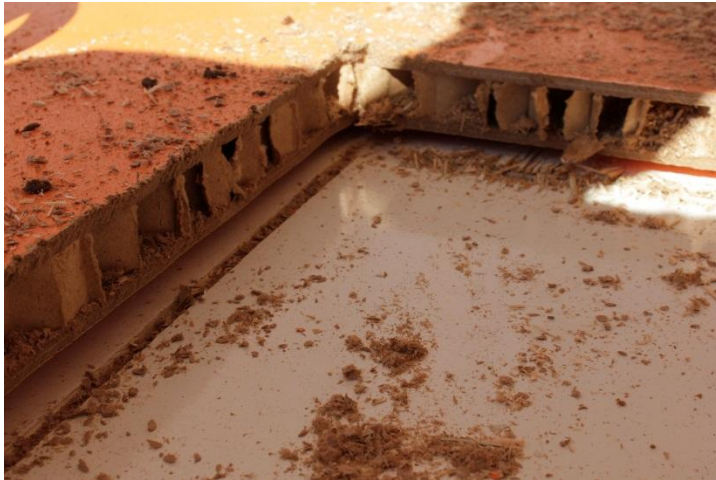
Kuva 3. 1971 vuoden ovi jonka ulko- ja sisäpinta on kaksinkertainen kovalevy, ulko ja sisäpinnan välissä on pahvikenno.
