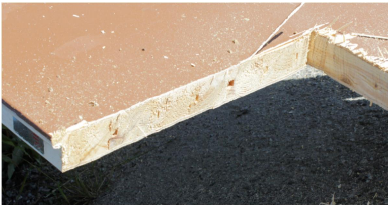
Kuva 5. 1963 vuoden ovi, "umpipuuvovi", ulko- ja sisäpinta on ohut vaneri, näiden välissä on ponttilaudasta tehty "umpipuutäyte".
