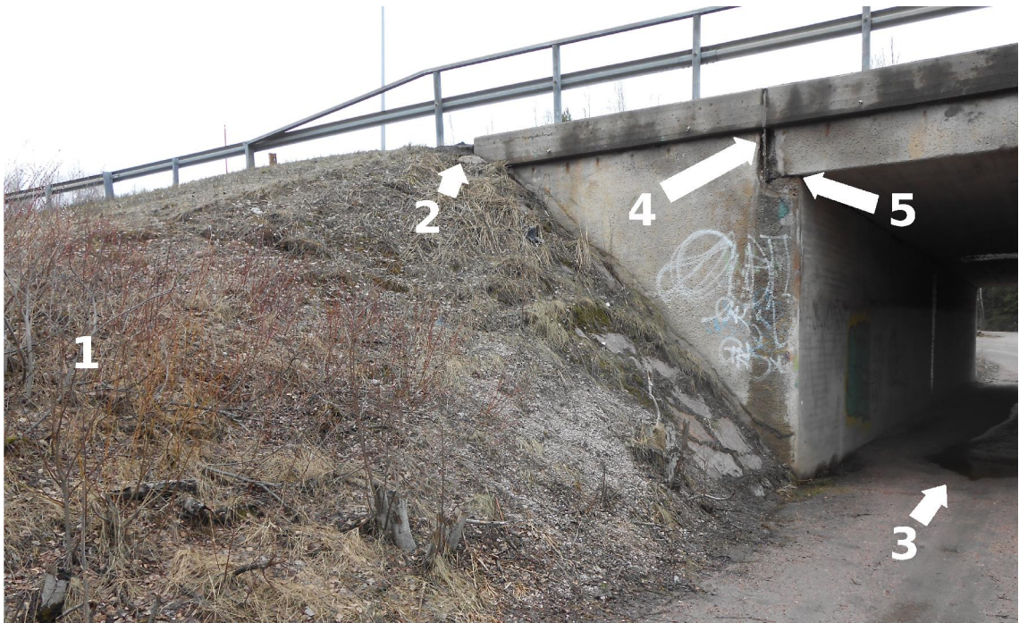
Kuva 4. Siltojen yhteydessä ilmenevät eroosioauriot. Siltojen eroosioauriot ilmenevät keilojen sortumina (1), maan karkaamisena tien rakenteen alta veden kuljettamana (2), kuivatusrakteiden kuten kourujen, putkien ja kaivojen (3) tukkeutumisena, sekä veden ja joskus myös kasvillisuuden kertymisenä saumoihin (4) ja laakeritasoille (5). [21, kuva: Sirkku Whitney]
