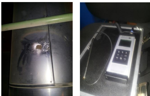
KUVIO 28. Poistokanavaan porattu mittausreikä sekä mittauslaite.
