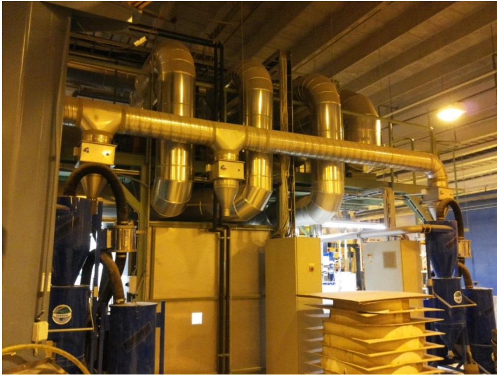
KUVIO 26. Kuorma-autokatalysaattoreiden kuivauslaitteisto takaapäin.
