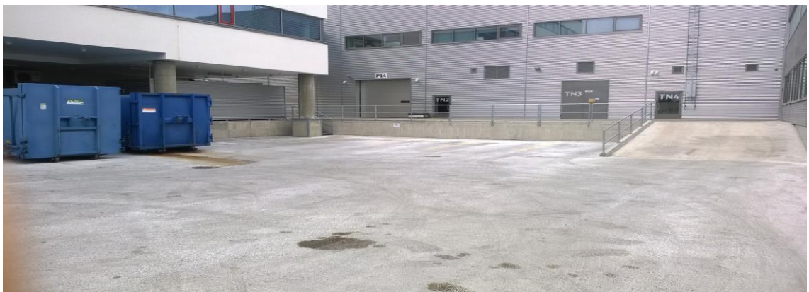
Kuva 20. Näkymä toimistorakennuksen ja terminaalirakennuksen välisestä korokealueesta [13].
