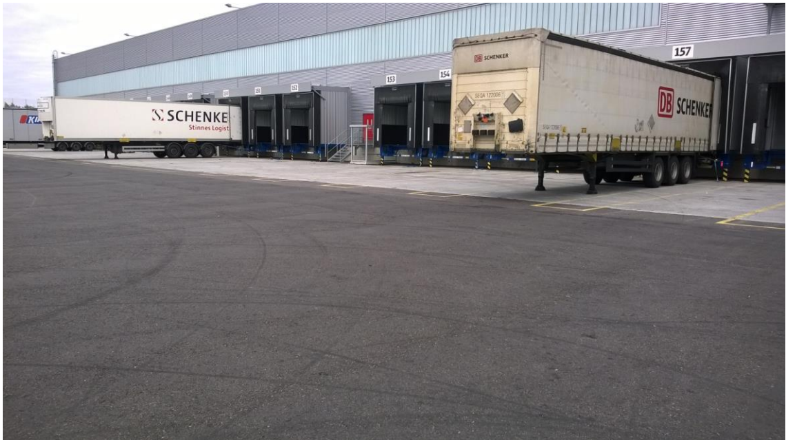
Kuva 12. Näkyvissä vientitoimintojen ja tavaravastaanoton käyttämiä lastausovia [13].
