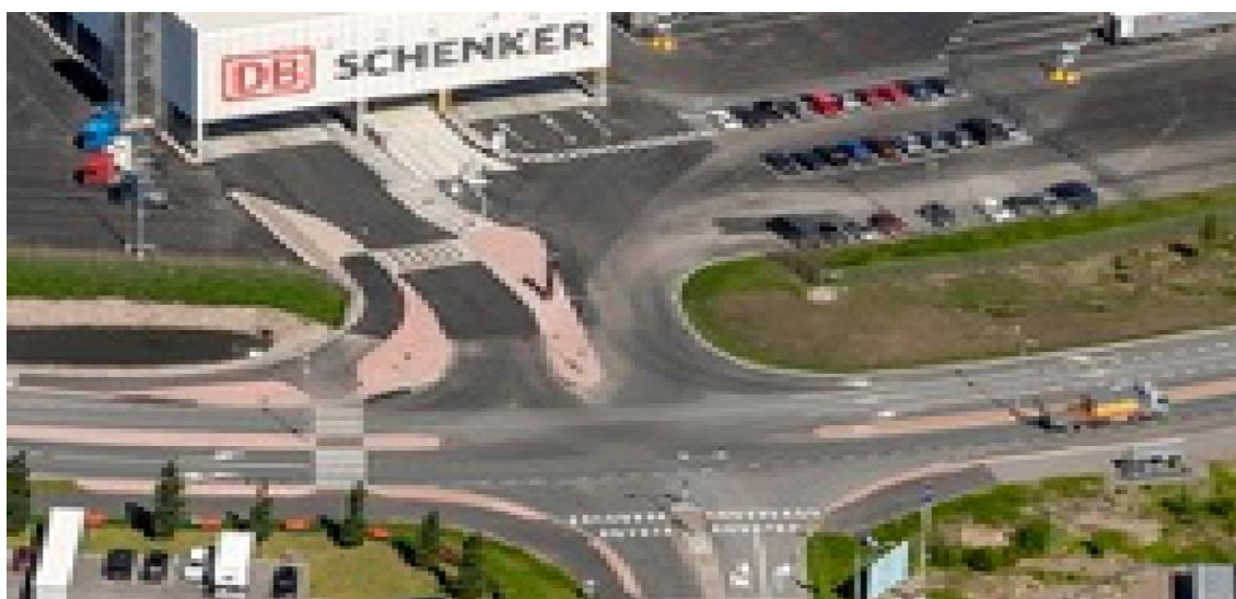
Kuva 24. Näkyvissä Tikkurilantie ja risteysalue sekä sisäänajovyylät Viinikkalan terminaali-alueelle [13].
