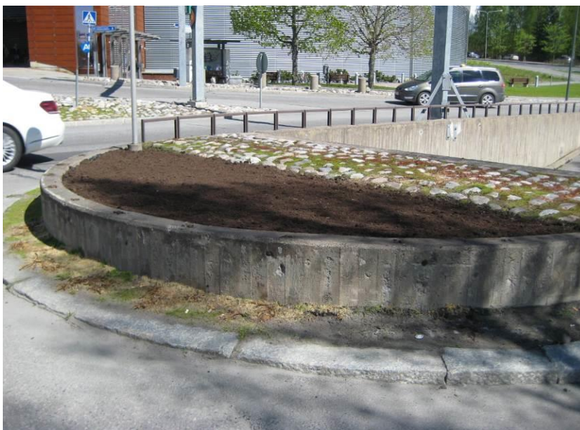
Kuva 5. Kevätkunnostuksen jälkeen kasvialusta muotoillaan siistiksi. Ympäröivät alueet siistitään multaroiskeita heti kevätkunnostuksen jälkeen.
