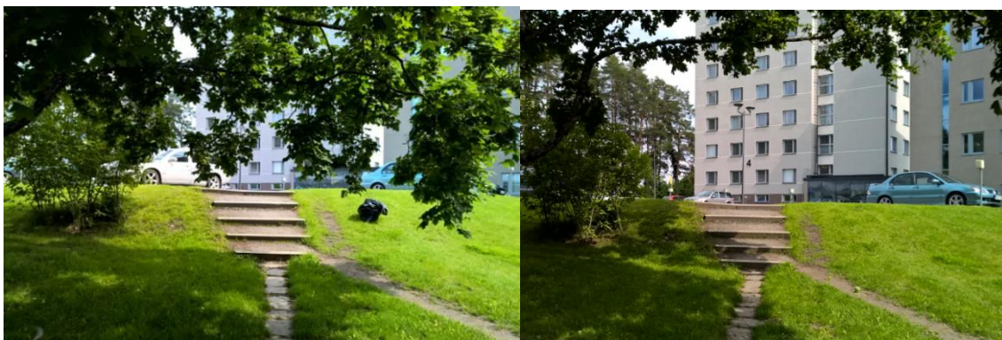
Kuva 21. Puiden leikkuissa huomioidaan esteettömän ympäristön vapaan korkeuden vaatimukset. Kulkuväylälle ei saa ulottua ylhäältä törmäysvaaran aiheuttavia esteitä, vapaan korkeuden tulee olla vähintään 2200 mm. Kuvassa puu ennen ja jälkeen leikkausta.
