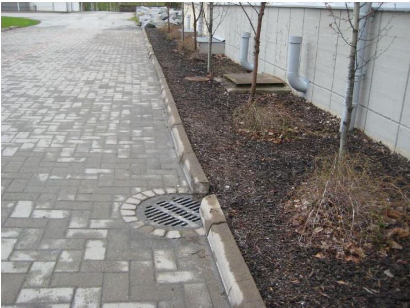
Kuva 27. Kaivojen suuaukot puhdistetaan muiden hoitotöiden yhteydessä. Erityisesti rankkasateiden aikana ja jälkeen hulevesikaivojen suuaukot puhdistetaan
