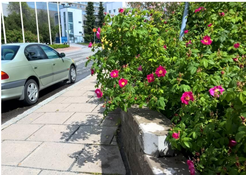
Kuva 13. Hoitamattomina kasvien versot voivat aiheuttaa vaaratilanteita käyttäjille esim. peittämällä terävät kulmat tai törmäysvaaran aiheuttavat rakenteet. Pensaiden kasvavat versot voivat myös esteettisen haitan lisäksi aiheuttaa mekaanisia vaurioita rakenteisiin.
