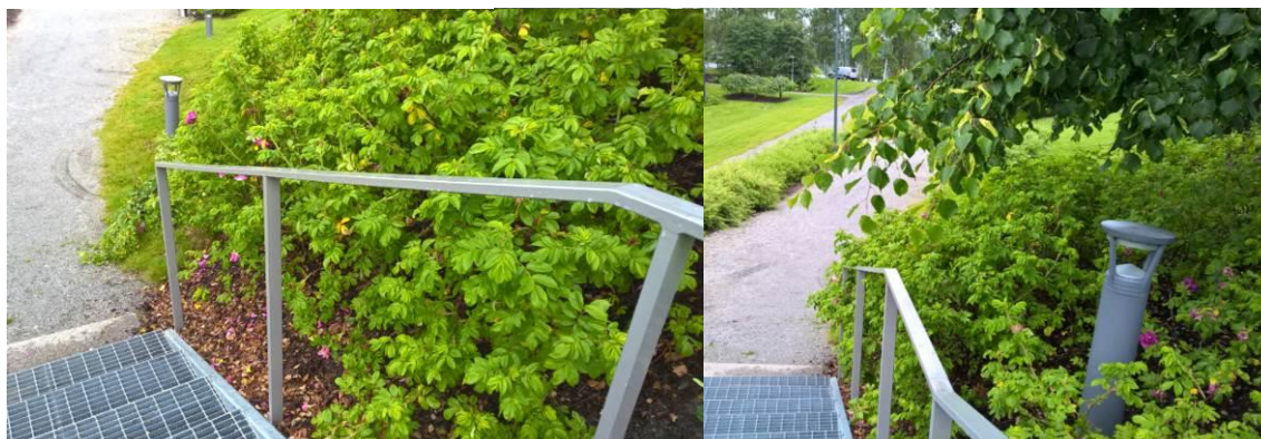
Kuva 15. Käsijohteiden on säilyttävä käyttökuntoisina ja esteettöminä koko portaiden matkan. Kasvillisuuden leikkauksilla huolehditaan, että rakenteet säilyvät käyttökuntoisina ja käyttäjäystävällisinä.
