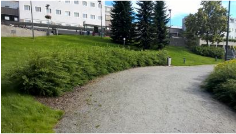
Kuva 26. Uusi oleskelualue tehdään KYS Puijon sairaalan rantapuistonon, norjanangervojen katveeseen. Oleskelualueelle asennetaan kaksi pöytäryhmää ja alue päällystetään betonikivellä.
