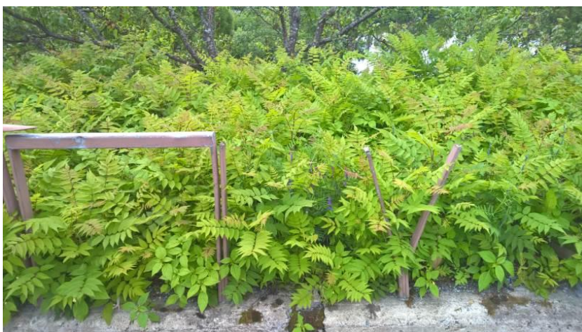
Kuva 35. Suojakaiteiden on säilyttävä käyttötarkoituksen mukaisina ja turvallisina. Rikkonaiset suojakaiteet korjataan välittömästi tai vauriokohdat merkitään varoitusvälinein.
