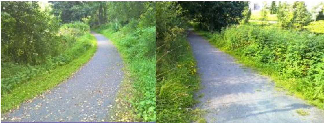
Kuva 5. KYS Puijon sairaalan Pienen Mustinlammen rannan kulkuväylien leveytenä tulee säilyä 1800 mm, jolloin kulkuväylät mahdollistavat pyörätuolien kohtaamisen.
