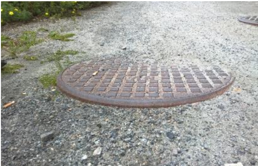
Kuva 12. KYS Puijon sairaalan rantapuiston kulkuväylien koholla olevia kaivon kannet aiheuttavat kompastumisvaaran liikkumis- ja toimintaesteisille ulkoympäristön käyttäjille.
