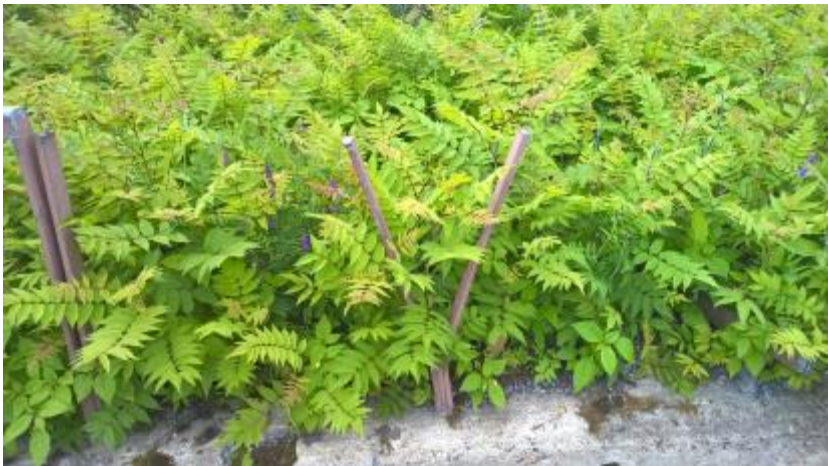
Kuva 52. KYS Puijon sairaalan ulkoympäristön suojakaiteet ovat huonokuntoisia ja vaarallisia.
