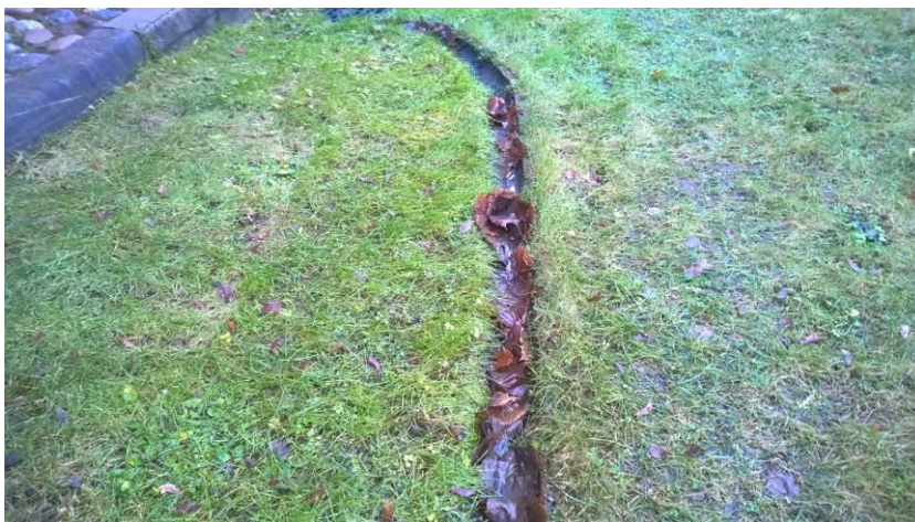
Kuva 31. Erityisesti vesisateiden aikana kourut puhdistetaan, jotta vesi ei pääse tulvi- maan ympäröiville alueille.
