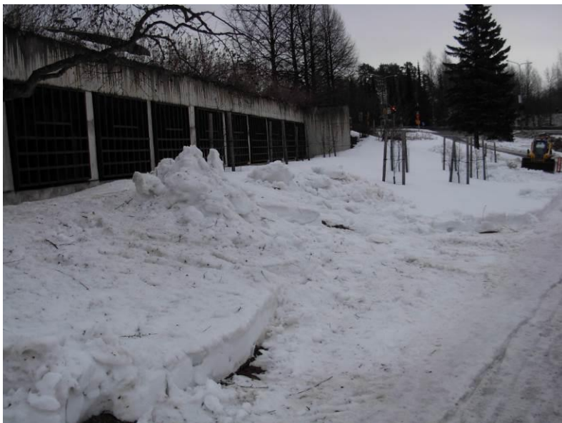
Kuva 4. Talvikunnossapidon aiheuttamat vauriot nurmikoille korjaa talvikunnossapitäjä.
