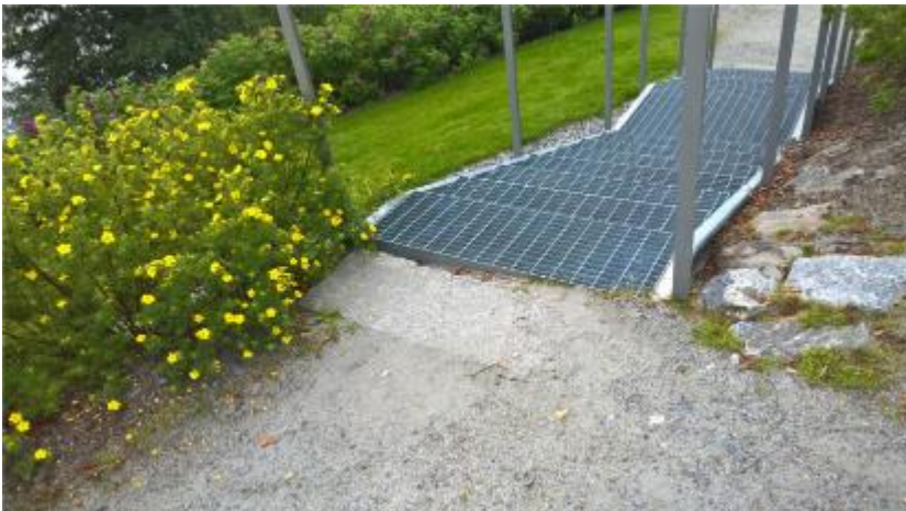
Kuva 47. KYS Puijon sairaalan rantapuiston portaiden ylä- sekä alapäähän asennetaan nystyrälaatoitus koko portaiden leveydeltä ja syvyydeltään 600 mm:n matkalta.
