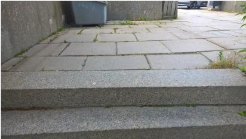
Kuva 49. Kaikkiin KYS Puijon sairaalan rantapuistoon johtaviin portaisiin asennetaan nystyrälaatoitus. Olemassa olevaa päällystettä puretaan nystyrälaatoituksen matkalta.
