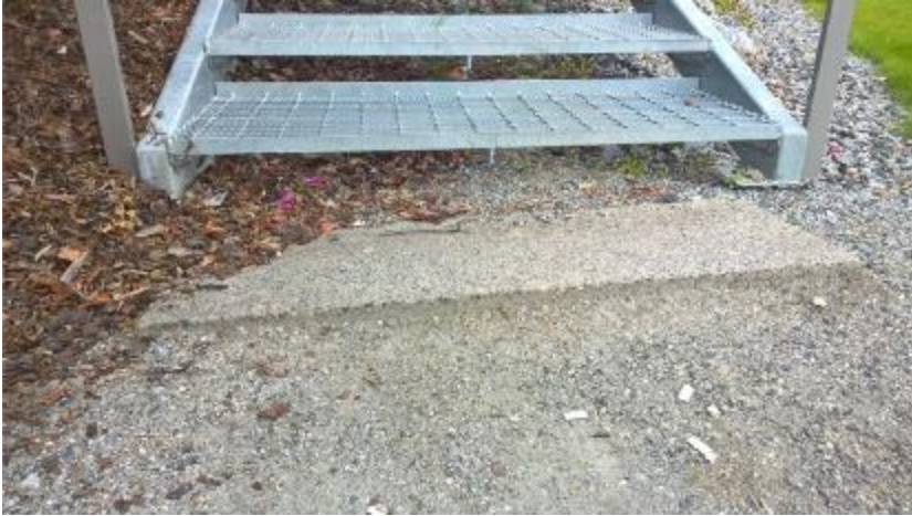
Kuva 48. KYS Puijon sairaalan rantapuistossa varoittava nystyrälaatoitus asennetaan portaiden molempiin päihin.
