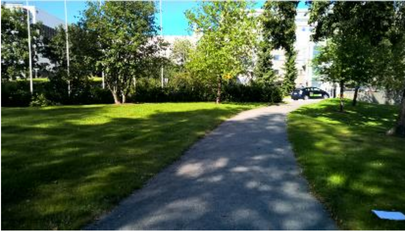
Kuva 4. KYS Puijon sairaalan rantapuiston sivukulkuväylien leveydeksi yhdenmukaisesti 1800 mm.
