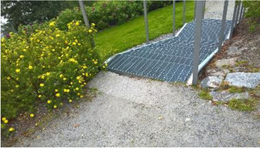
Kuva 14. KYS Puijon sairaalan rantapuiston vanhat teräsritiläportaat uusitaan leveydeltään 1200 mm:n teräsritiläportaisiin.
