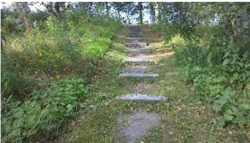
Kuva 15. KYS Puijon sairaalan rantapuistossa, Pienen Mustinlammen rannan portaiden vapaata leveyttä lisätään kasvillisuuden poistolla.
