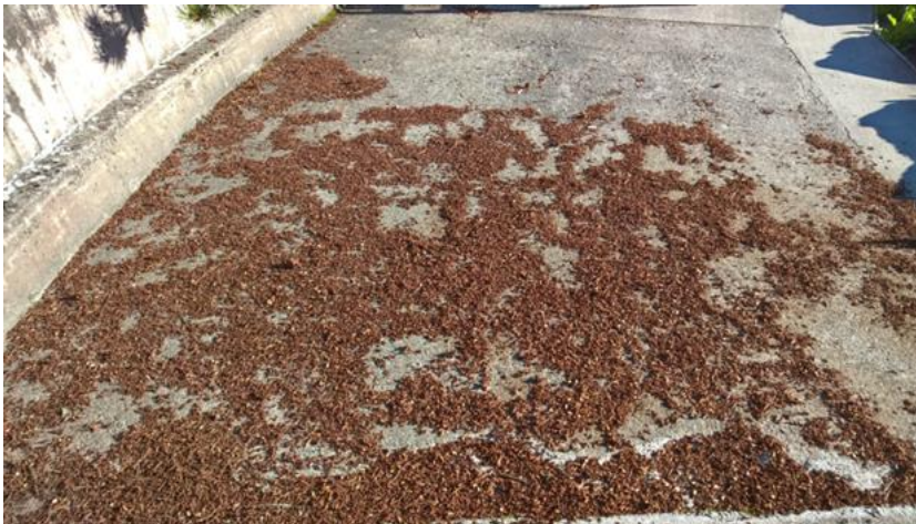
Kuva 22. Orgaaninen ainesta ei saa olla siinä määrin, että se aiheuttaa liukastumisvaaraan, haittaa apuvälineiden kanssa liikkumista tai alueiden tarkoituksenmukaista käyttöä.
